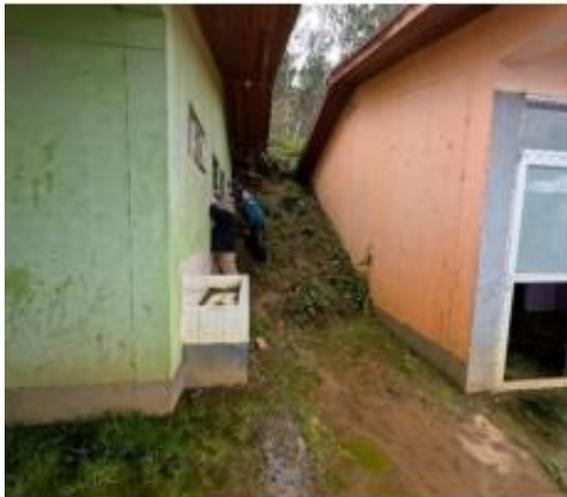
**Fotografía 8.** Se aprecia el material del deslizamiento que ha ingresado entre pabellón y pabellón.
