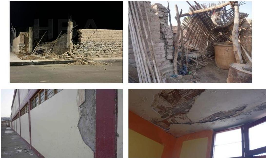
**Figura 9.-** Arriba: Viviendas de adobe en Yauca con fisuras y colapso de paredes (Fuente: HBA Noticias y Huaral.pe). Abajo: Colegio San Pedro de Yauca con daños como caída de estuques de paredes y techos (Fuente: Sin Fronteras).
