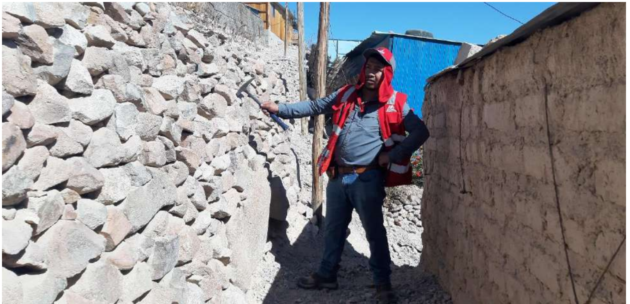
FOTO 33: Vista de los muros precarios con pircado de piedras en las 3 asociaciones del ámbito de estudio
