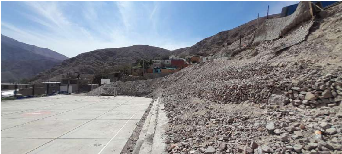
FOTO 24: Vista de la Mz G3 en la Asoc. Alto Samegua con construcciones precarias y taludes escarpados sin medidas de protección ante deslizamientos.
