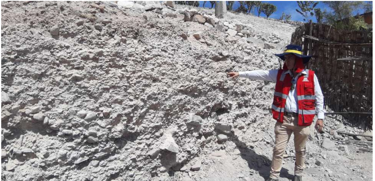
FOTO 32: Visita de campo a la zona de Alto Samegua a los taludes existentes y verificación del estado situacional
