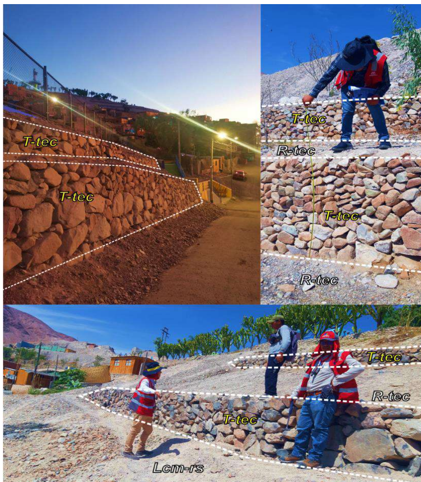
FOTO 9: Talud tecnogénico (T-tec)
