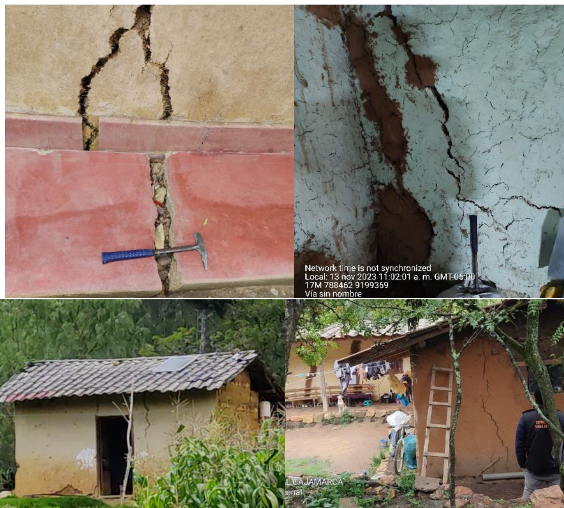
Fotografía 3. Algunos agrietamientos en viviendas producidos por la reptación lenta de los suelos. Coordenadas: E: 788465; N: 91990294 (arriba izquierda); E: 788462; N: 9199369 (arriba derecha); E: 788329; N: 9199140 (abajo izquierda) y E: 788443; N: 9199223.
