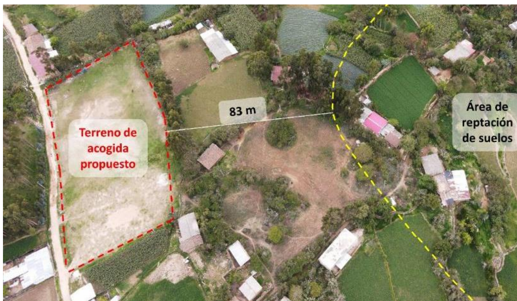
Figura 12. Vista de la zona de acogida propuesta y su distancia a la zona en proceso de reptación.
