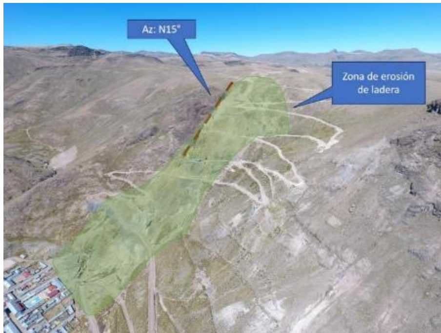
Figura 6. Cerro Amayane con presencia de ladera erosionada, tipo erosión laminar.
