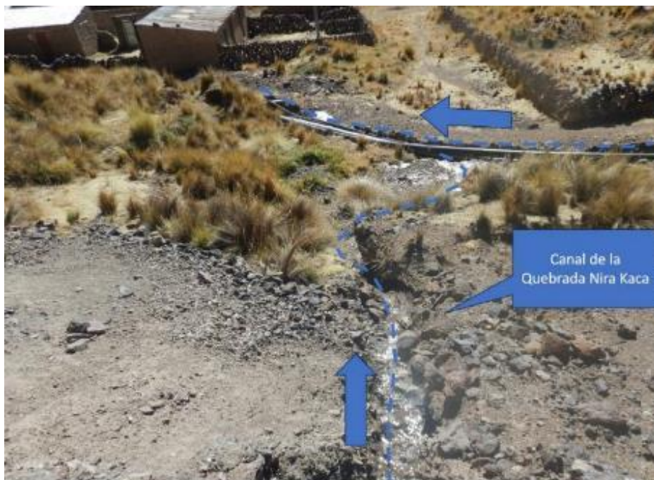
Figura 9. Las aguas de la quebrada Naira Kaca a la altura de la ciudad se canaliza, para desembocar en el río Llanasalla.
