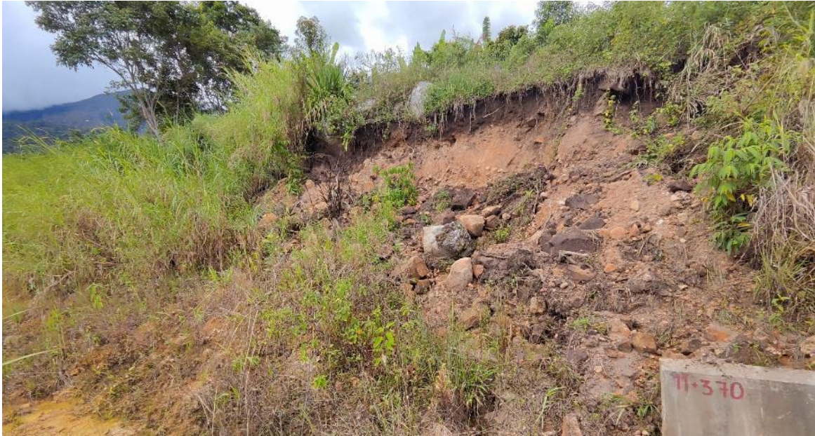
Fotografía 4. Vista de los depósitos coluviales originadas por el deslizamiento en el CP. Potrerillo.
