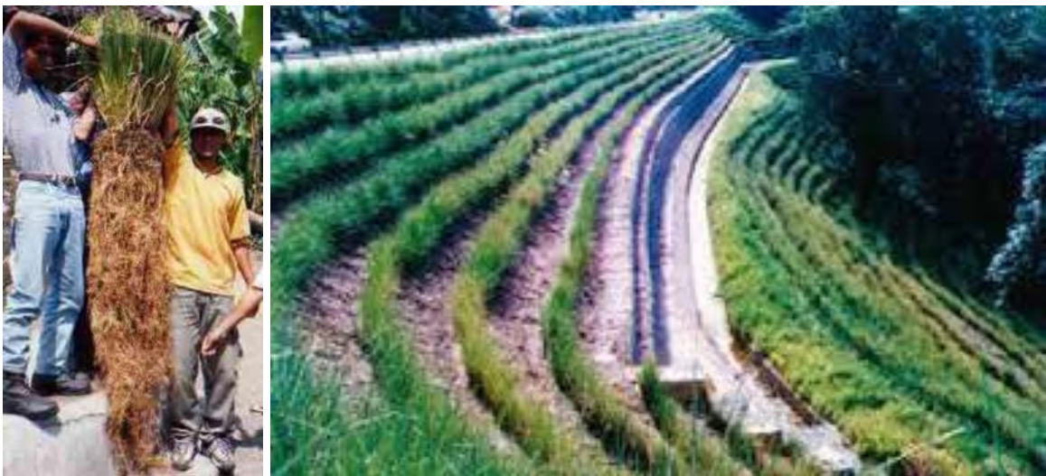
Figura 19. Ejemplo de bioingeniería con arbusto (vetiver) en taludes de materiales sueltos.
