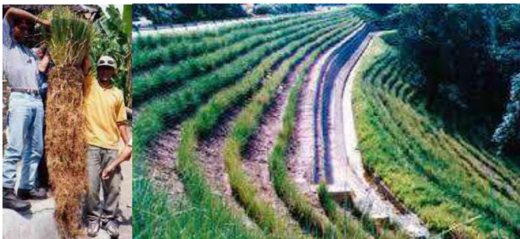
Fotografía 2. Ejemplo de bioingeniería con arbusto (vetiver) en taludes de materiales sueltos.
