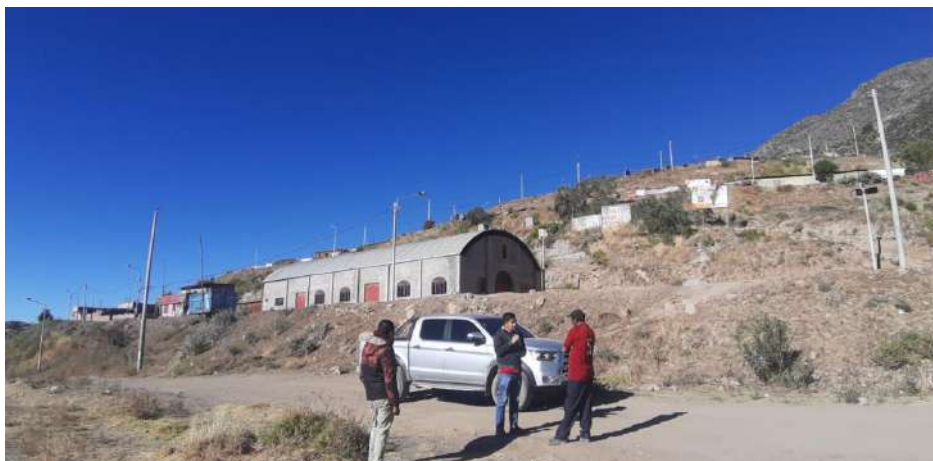
FOTO 23: INFRAESTRUCTURA CULTO - IGLESIA CCP AMANTA
