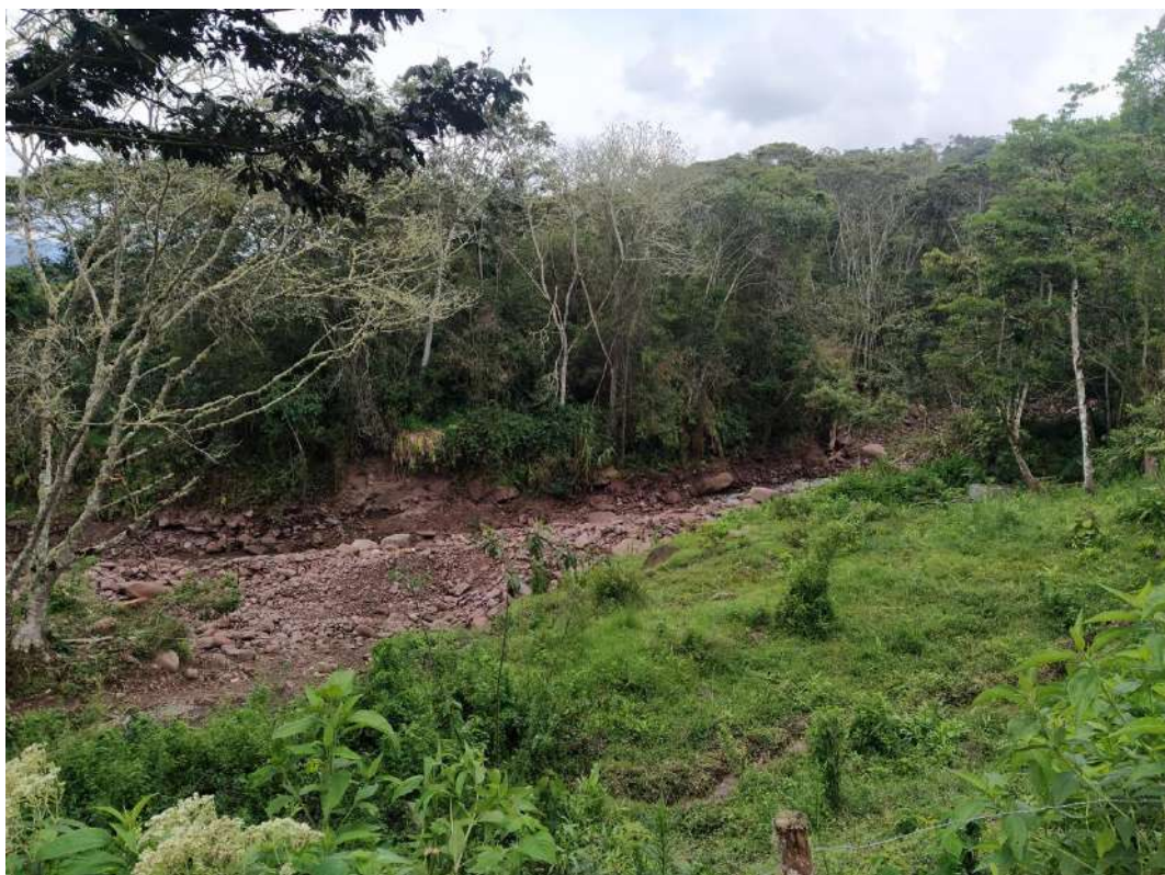
Fotografía 12. Se observa la colmatación del cauce de la quebrada San Luis en las coordenadas UTM, WGS 84, 18s, X:457809 Y: 8830228.
