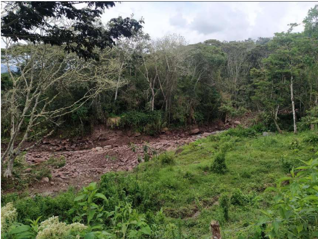
Fotografía 6. Depósito proluviales en la quebrada San Alberto. Coordenadas UTM, WGS 84, 18s, X: 457264.93, Y: 8831251.49 ).
