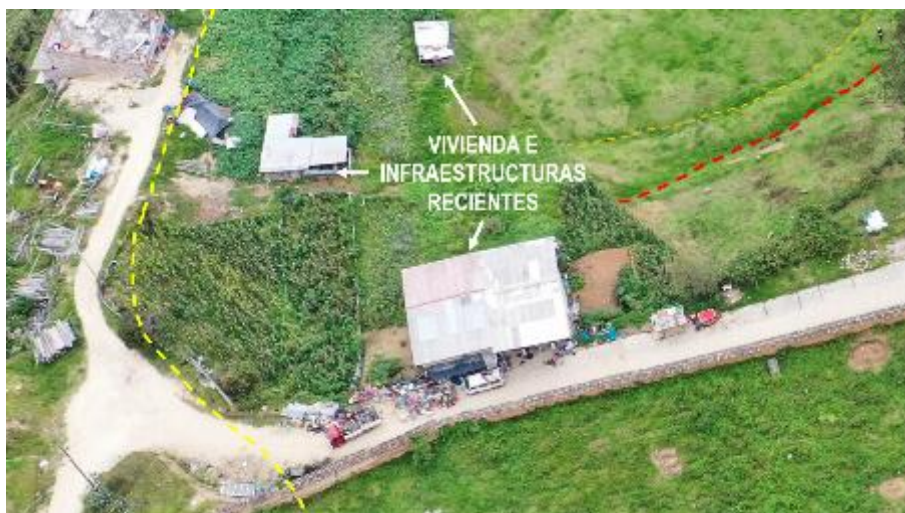
Figura 14. Vista de las viviendas e infraestructuras recientes, construidas en el cuerpo del deslizamiento.
