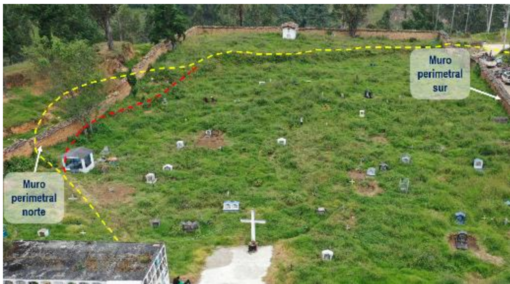
Figura 12. Vista de la parte alta del deslizamiento, donde se aprecia el terreno y los muros perimetrales del cementerio San Juan, afectados; el cuerpo del deslizamiento está delimitado en línea amarilla y el escarpe secundario en línea roja.
