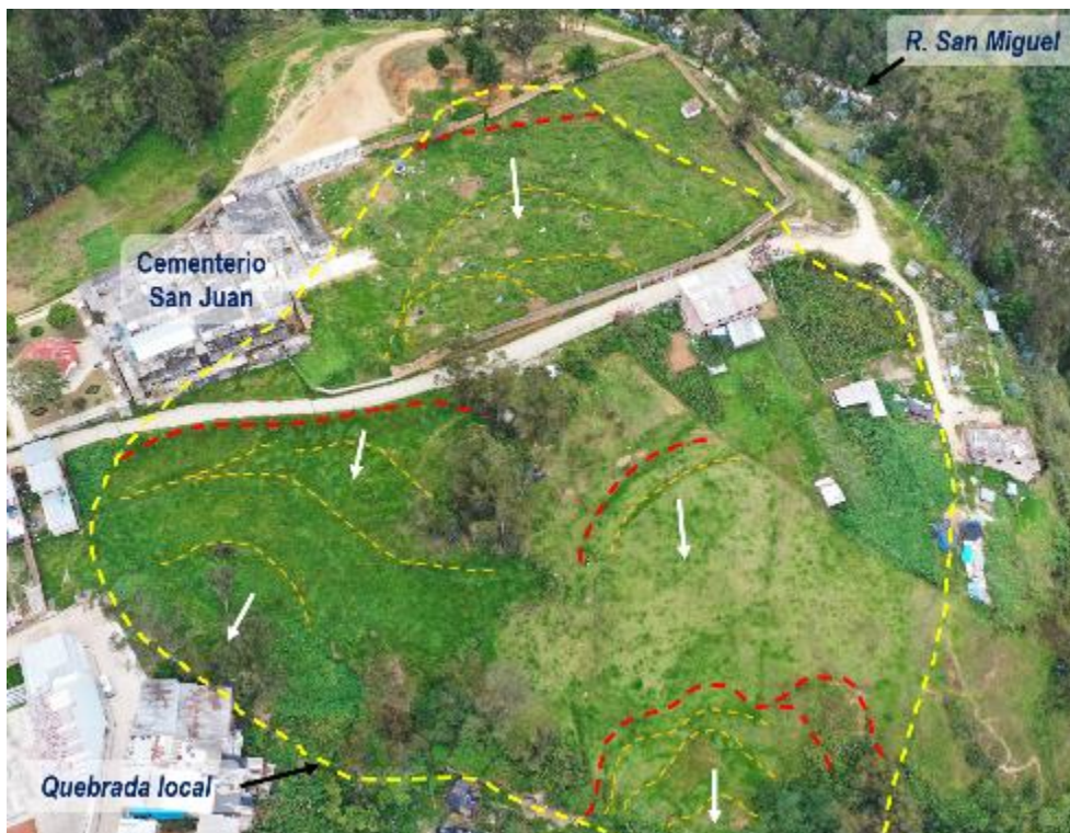
Figura 9. Vista del deslizamiento del Cementerio San Juan, se aprecia el cuerpo del deslizamiento (delimitado en línea amarilla), escarpes secundarios (en línea roja) y agrietamientos transversales (en línea naranja).
