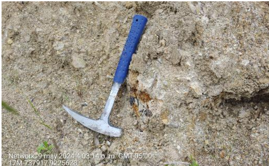
Fotografía 1. Macizo rocoso de depósitos piroclásticos muy fracturados y altamente meteorizados de la unidad Centro Volcánico Anchipan - Mutis - Evento 2. Ubicación: E: 737917, N: 9225628, Z: 2600.
