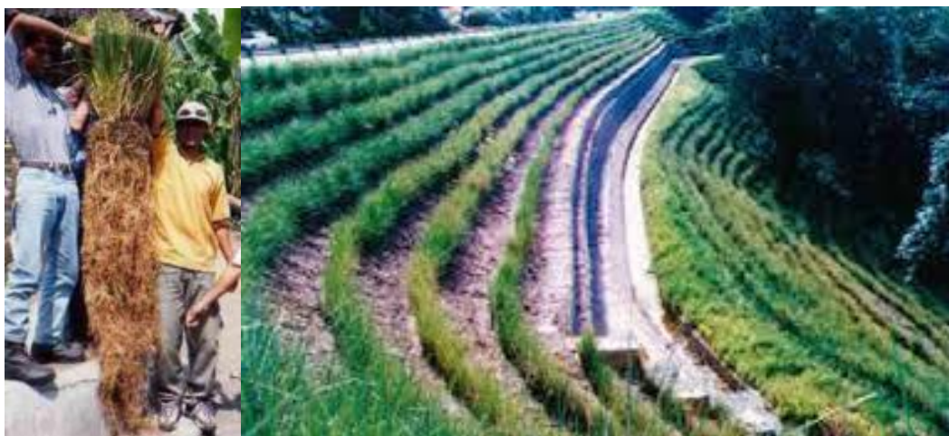
Fotografía 7. Ejemplo de bioingeniería con arbusto (vetiver) en taludes de materiales sueltos.
