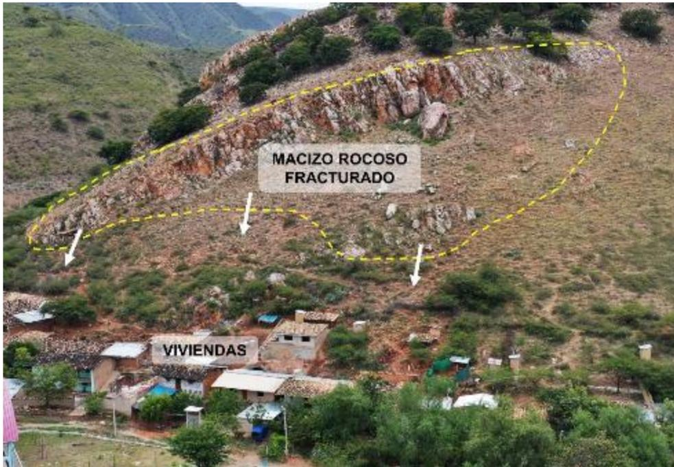
**Figura 15.** Vista del sector noroeste de Cholocal, destacando el sector con macizos rocosos fracturados desde donde se desprenden bloques ladera abajo.
