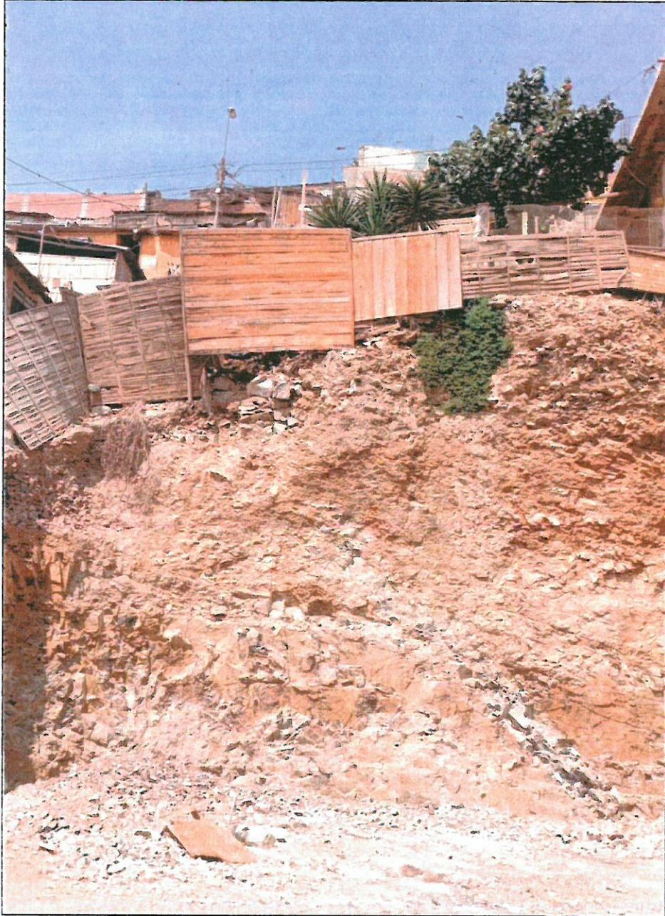
Foto 19: La forma de ocupación del territorio sin planificación, sumado a la geomorfología existente, calidad del suelo, pendientes pronunciadas, condiciones sísmicas propias de la zona, ha resultado en alto riesgo para los habitantes de las laderas de los cerros del sector catastral 33-35.
