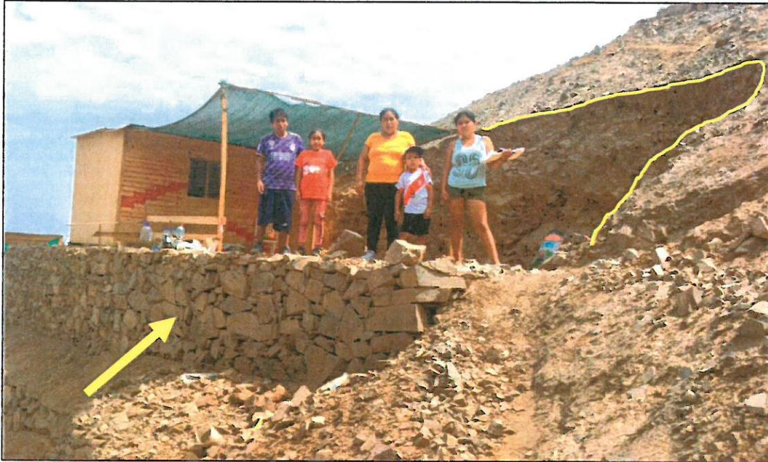
Foto 12: Modificaciones a la morfología natural del terreno mediante cortes y rellenos sobre las laderas.
