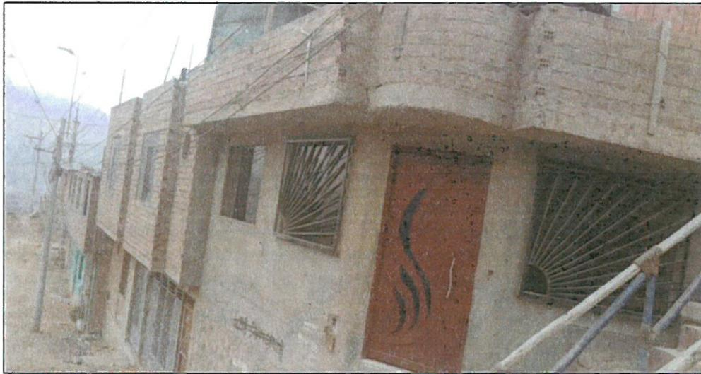
Foto 7: El sistema de albañilería que han usado para la construcción de las viviendas no está conforme lo establece la Norma Técnica E.070 del RNE, ya que la construcción está realizada con ladrillos pandereta y las columnas en su gran mayoría son de 0.25 x 0.25m con 4 fierros de 1/2".
