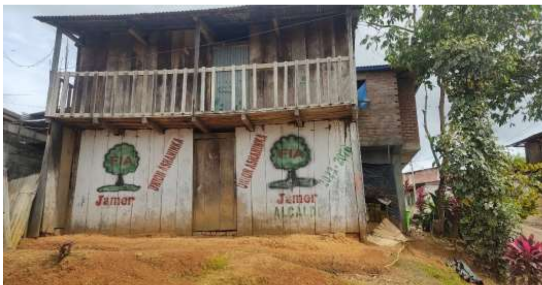
Fotografía N° 10. Vivienda con material de construcción tipo madera y calamina estos son los más predominante en paredes en la comunidad.
