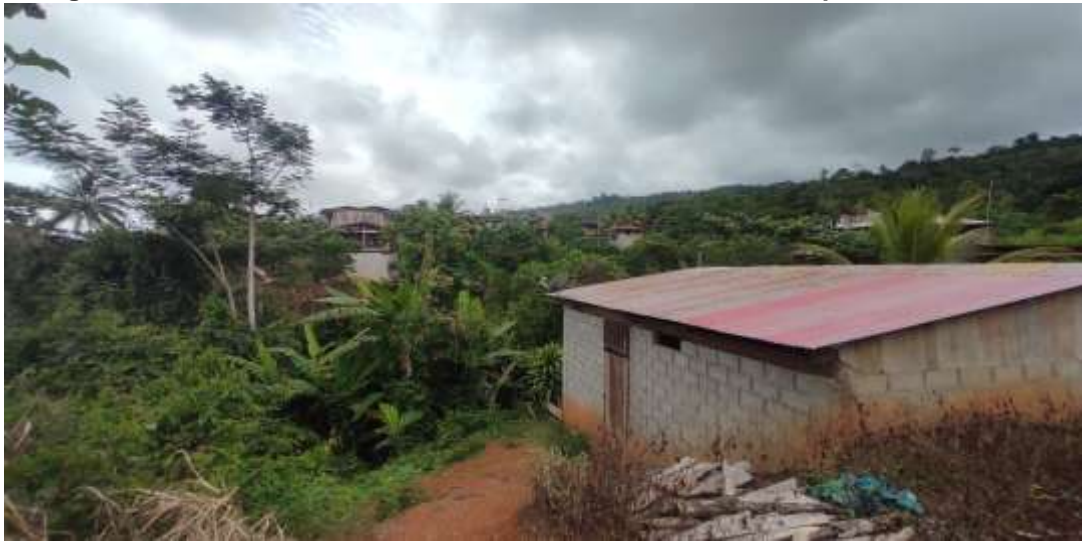
Fotografía N° 9. Viviendas construidas con materiales de tipo material noble.
