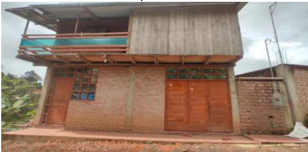
Fotografía N° 7. Vivienda con material de construcción tipo cemento o bloquetas de las paredes exteriores.
