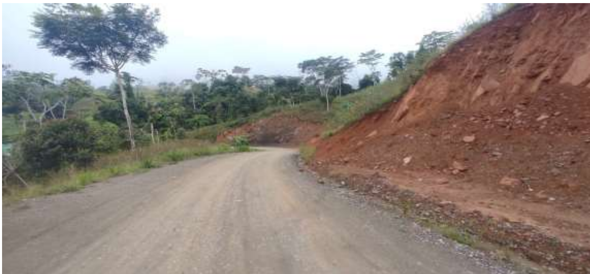
Fotografía N° 28. Depósitos coluviales en el sector de ingreso a la comunidad San Inés
