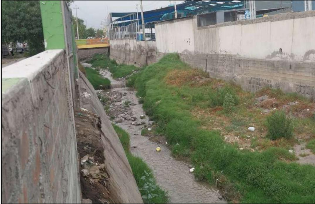
Fotografía N° 4: Se observa que el muro de contención no está en buenas condiciones y además presenta muros de ladrillos que no ofrecen mayor protección.
