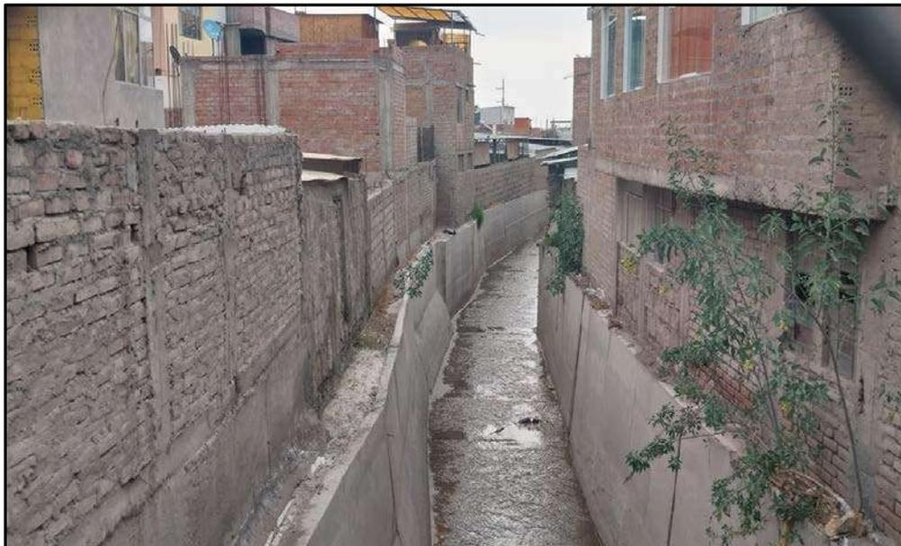
Fotografía N° 10 : Vista aguas abajo de la torrentera que se encuentra canalizada, se observa que el canal ha reducido sus dimensiones en cuanto a su sección de paso.
