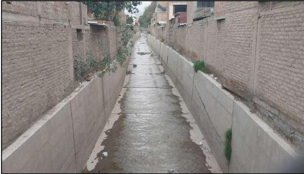
Fotografía N° 8 : Vista aguas abajo de la torrentera que se encuentra canalizada, el hay presencia de escorrentía pluvial que proviene de las partes altas
