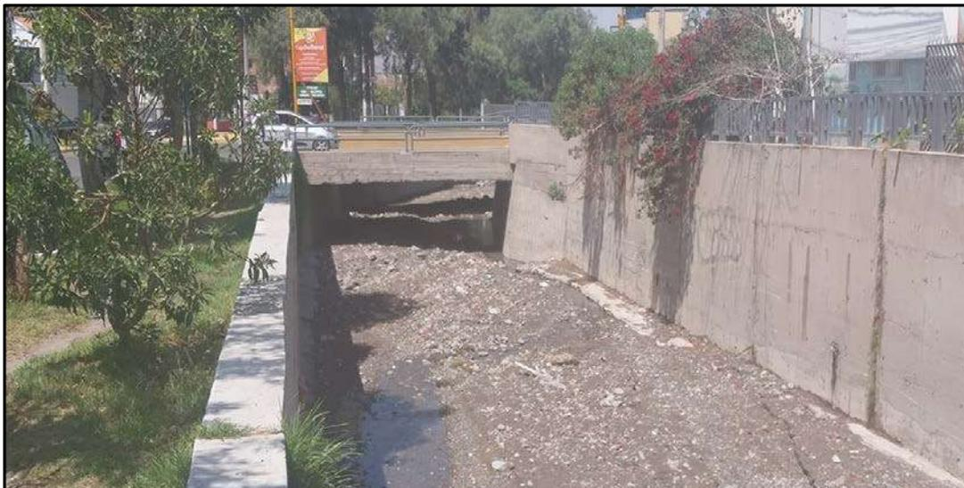
Fotografía N° 6 :El muro de contención de la margen izquierda, es más susceptible que pueda sufrir desbordes por flujos de detritos, ya que no presenta una buena altura.
