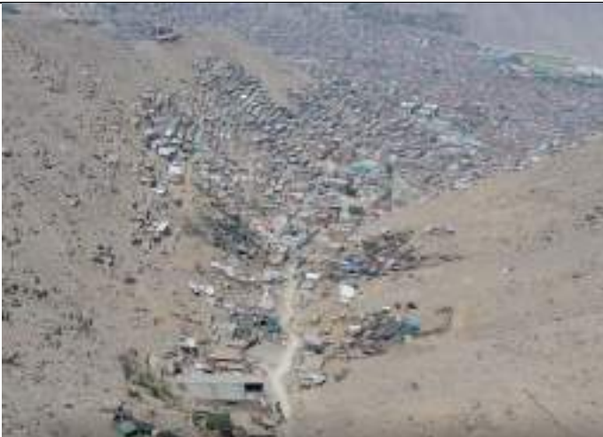
VIVIENDAS EN LAS LADERAS DE LA AMPLIACION DE LA ZONA N
