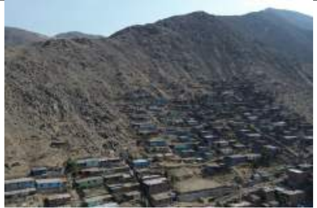
VIVIENDAS ASENTADAS EN LADERAS DE FUERTE PENDIENTE, SOBRE PIRCAS DE PIEDRAS EN LA ZONA Q.
