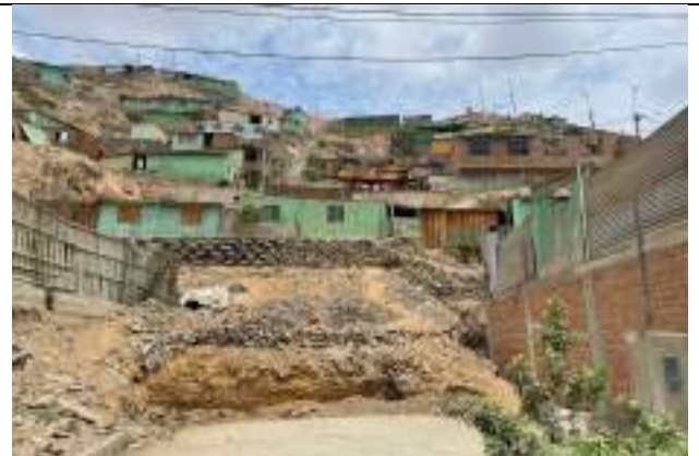
VIVIENDAS ASENTADAS EN LADERAS INESTABLES AMP. LOS OLIVOS
