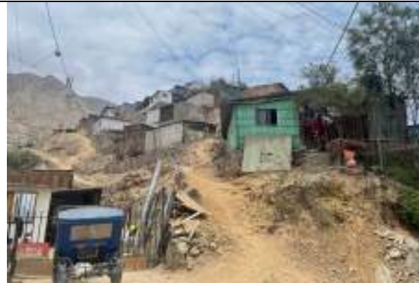
VIVIENDAS PRECARIAS EN LA ASOC. LOS EUCALIPTOS ZONA I
