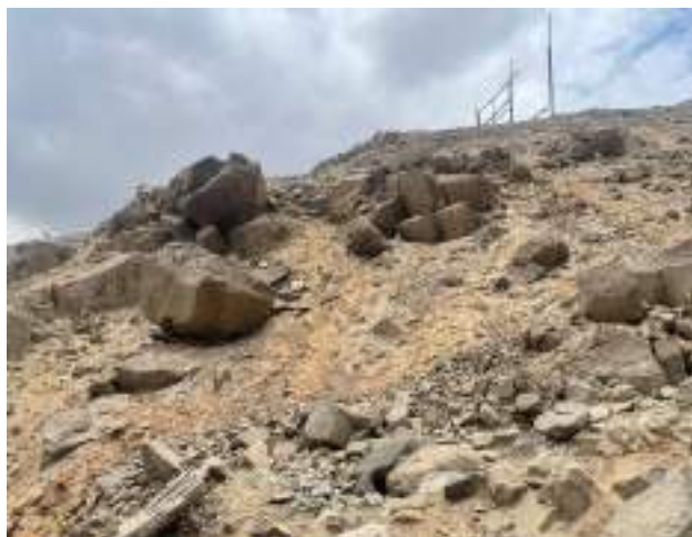
LADERAS CON MATERIAL DE ROCA SUELTA QUE EVIDENCIA EL PELIGRO POR CAIDA O VOLCAMIENTO
