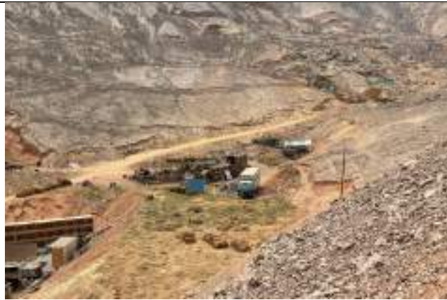
OCUPACION DEL CAUCE DE QUEBRADA EN LA AMPLIACION DE LA ZONA R
