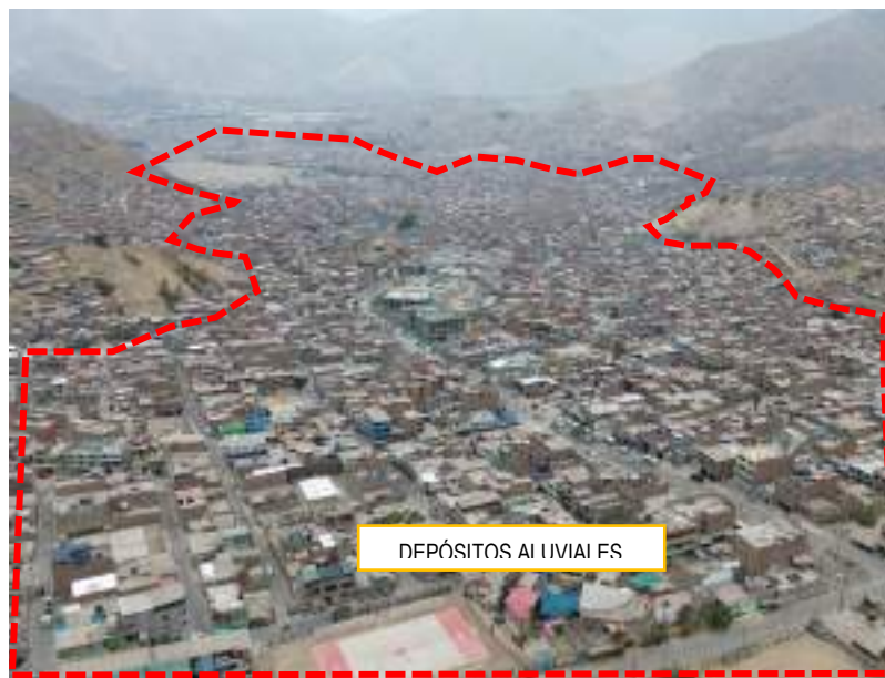
Viviendas asentadas sobre gran depósito aluvial de la quebrada Huaycán
