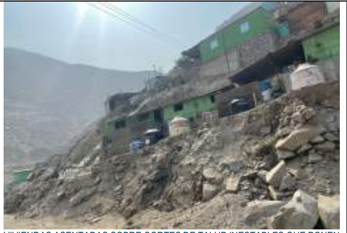
VIVIENDAS ASENTADAS SOBRE CORTES DE TALUD INESTABLES QUE PONEN EN RIESGO DE COLAPSO POR DERRUMBES
