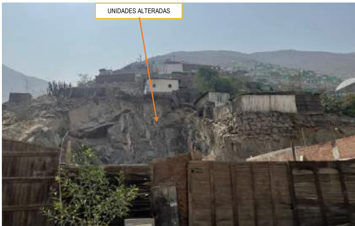
Viviendas asentadas sobre material rocoso fracturado en zonas inestables.
