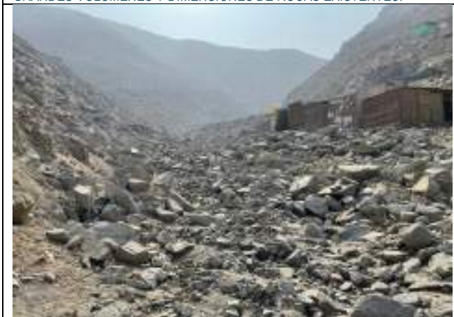
VIVIENDAS OCUPANDO MUY CERCA AL CAUCE DE LA QUEBRADA
