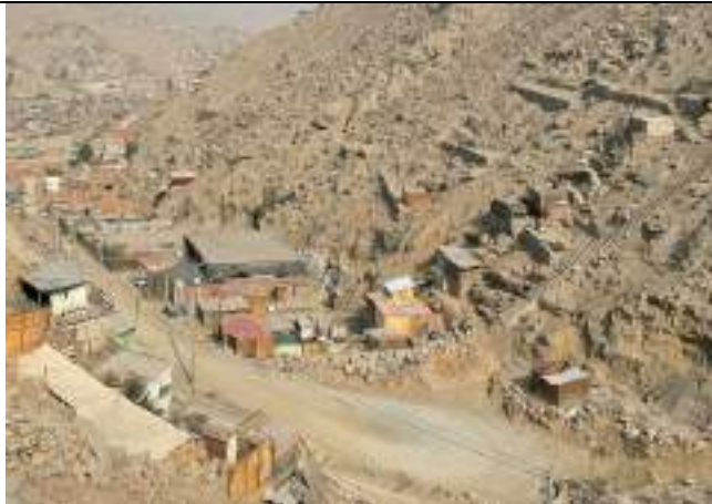
VIVIENDAS PROXIMAS AL CAUCE QUE SE HA IMPROVISADO COMO VIA DE ACCESO EN LOS JARDINES DE HUAYCAN
