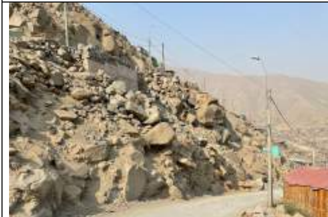
CORTE DE LADERA EN LA ASOCIACION LA FORTALEZA EVIDENCIA LOS GRANDES VOLUMENES Y DIMENSIONES DE ROCAS EXISTENTES.
