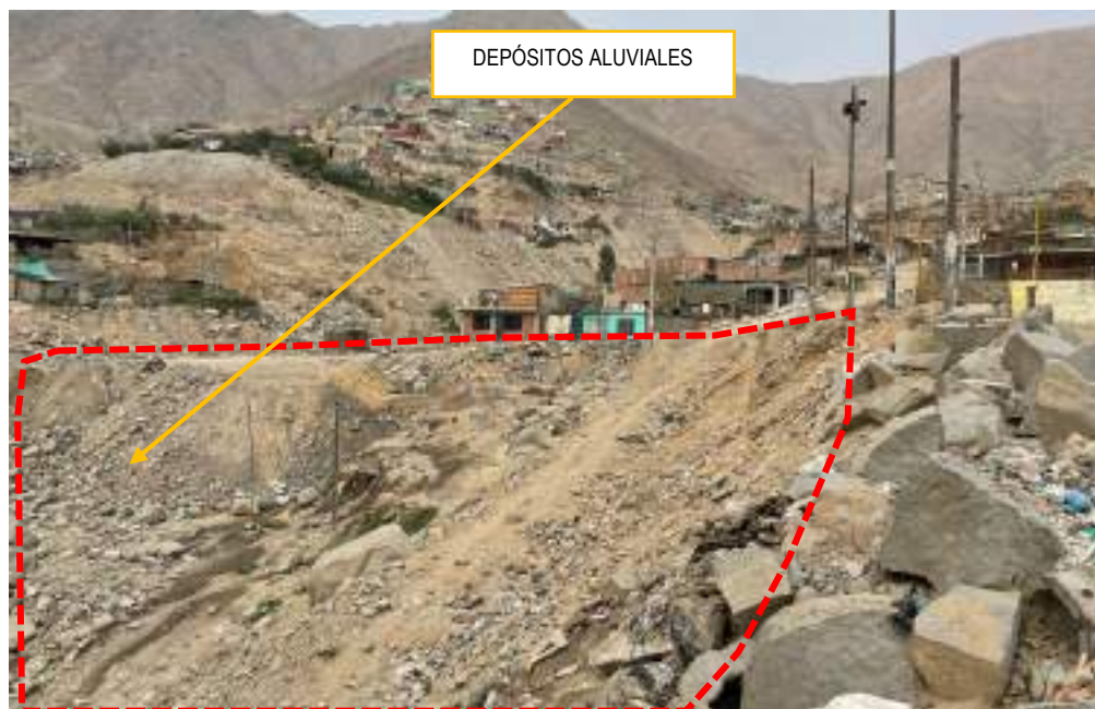
Zona de depósitos aluviales en la zona Z de Huaycán
