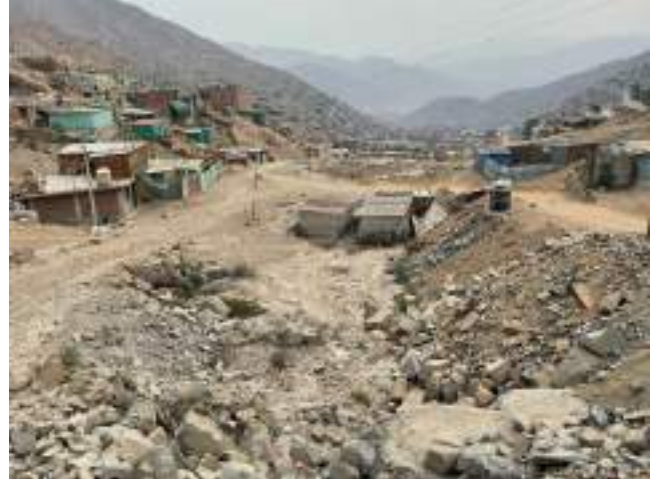
VIVIENDAS EN MEDIO DEL CAUCE DE LA ZONA Z.
