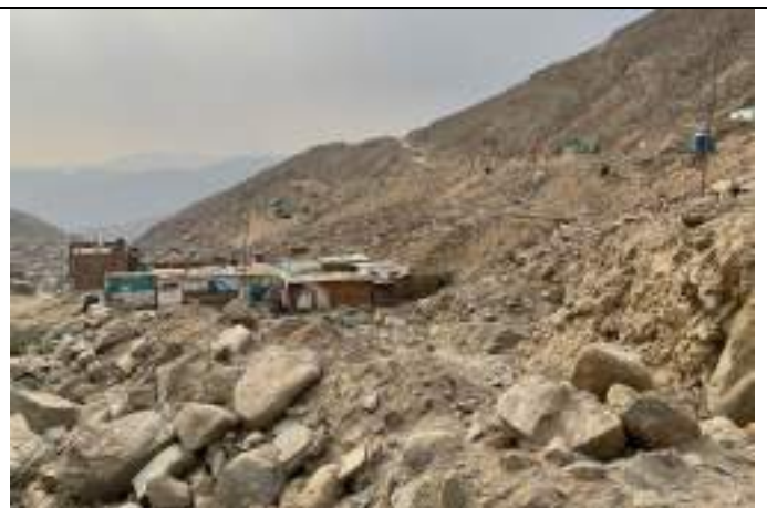
TRABAJOS DE DESQUINCHE EN LADERAS PARA LA OCUPACIÓN DE VIVIENDAS.
