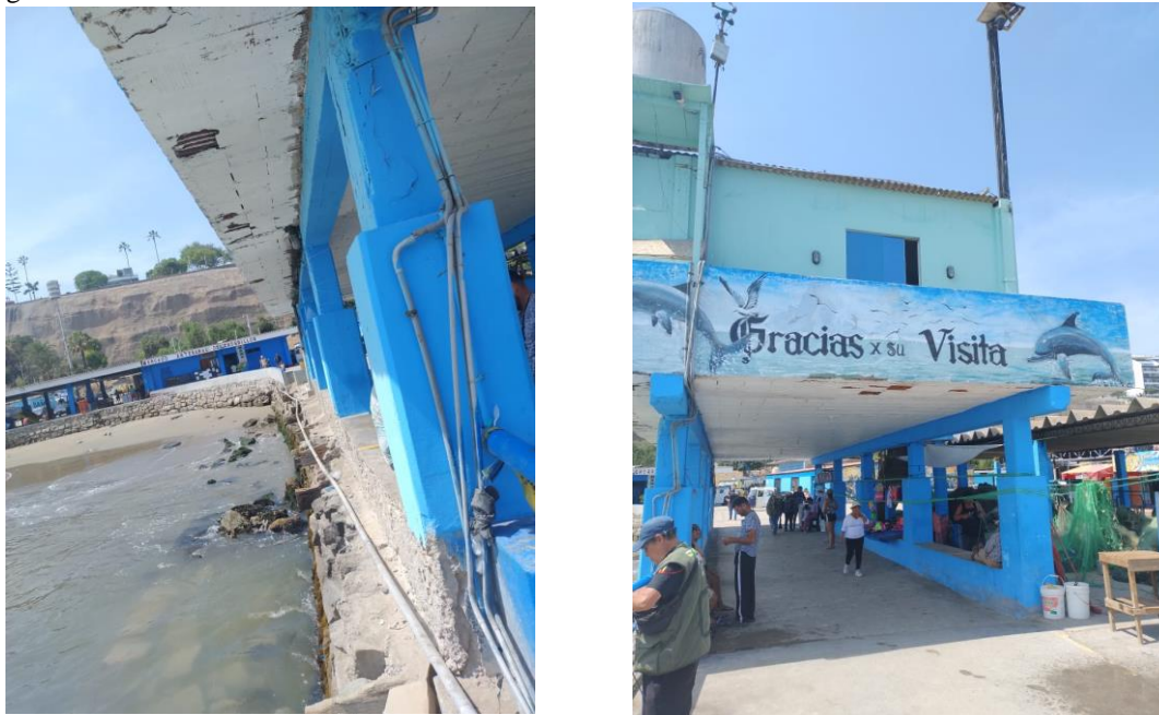
Figura 24: Bases estructurales del local administrativo del MA de Chorrillos
