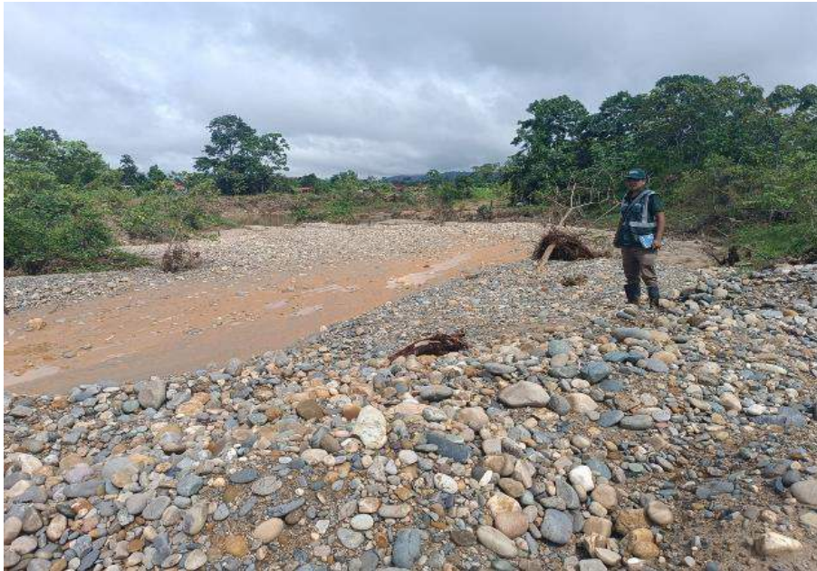
Imagen 01: Se aprecia el lecho del Rio con material colmatado y riberas erosionadas.
