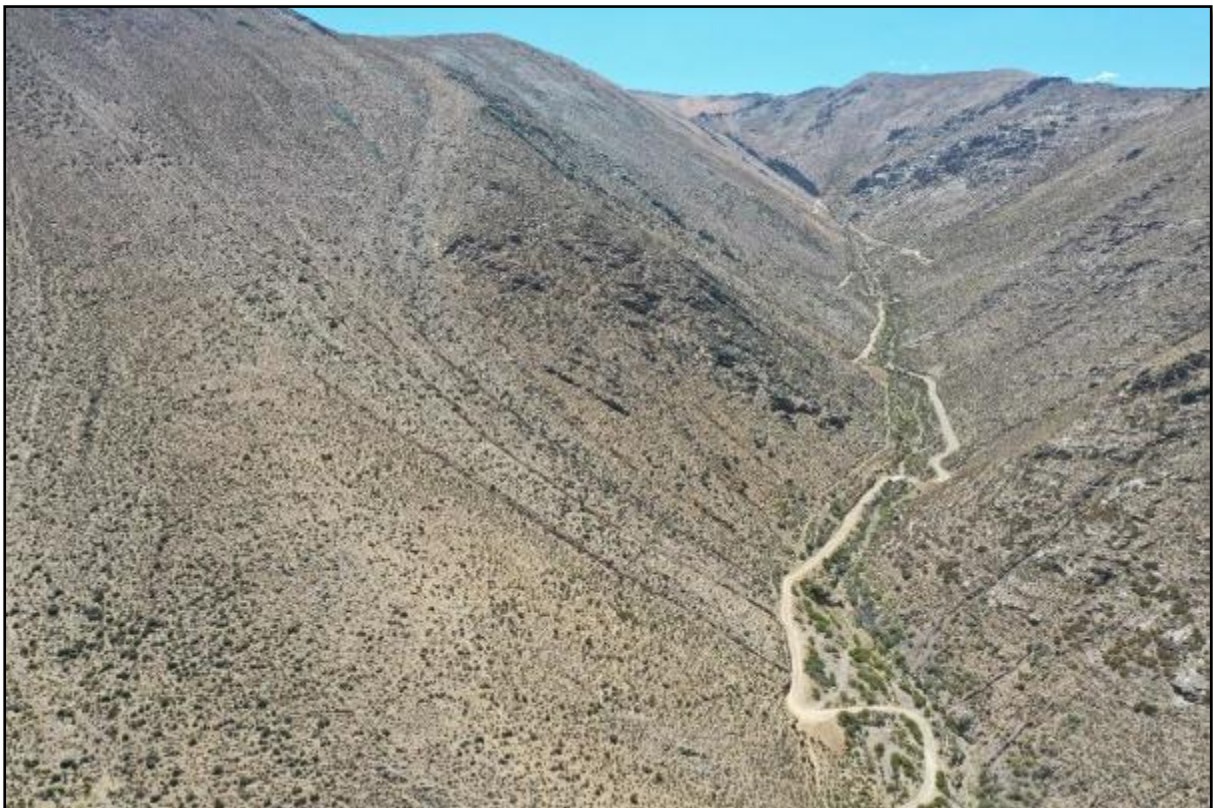
Fotografía 5. Procesos de erosión de ladera en la margen Derecha de la quebrada Ataspaca.
