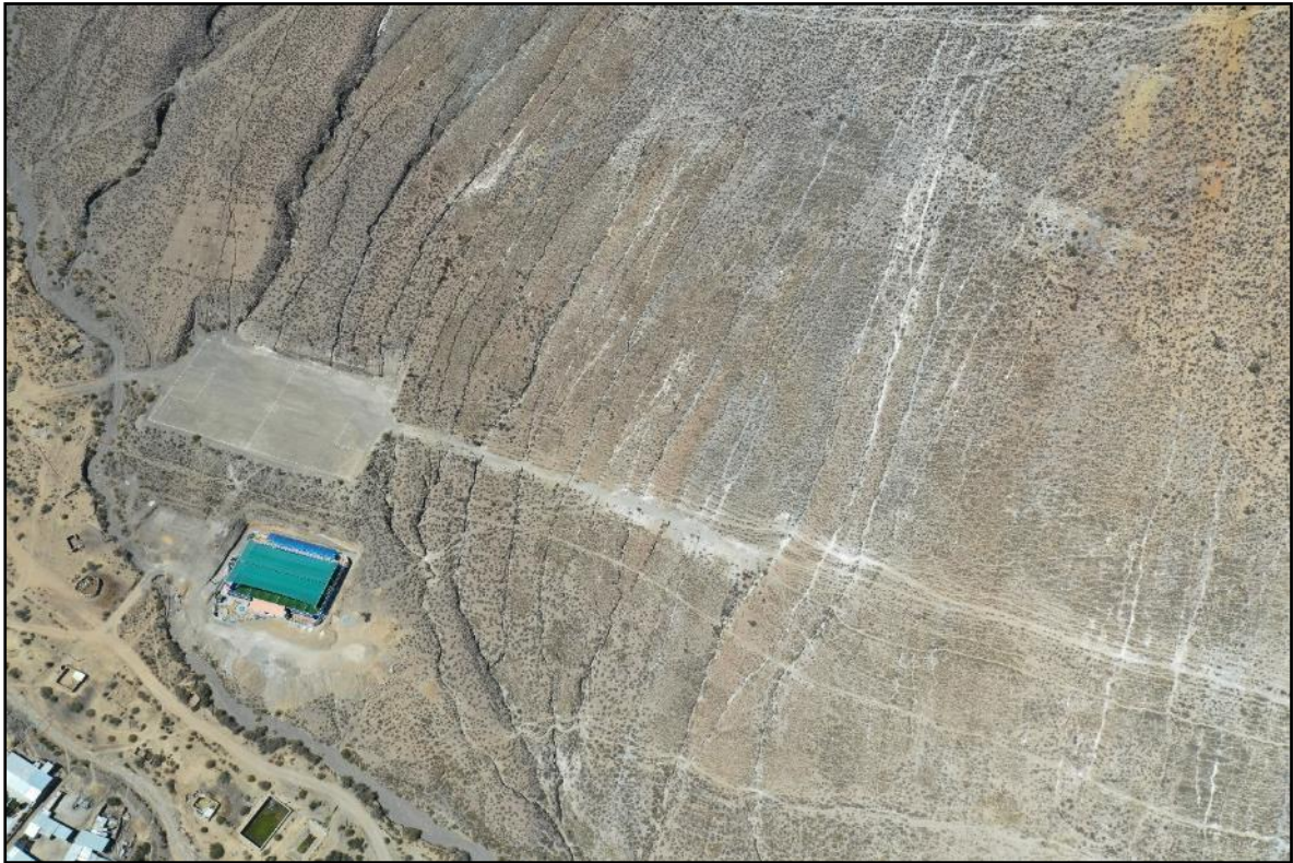
Fotografía 4. Procesos de erosión de ladera en la margen izquierda de la quebrada Ataspaca.
