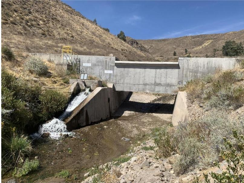
**Fotografías 8** Bocatoma del canal 9, dotación de agua para riego.
