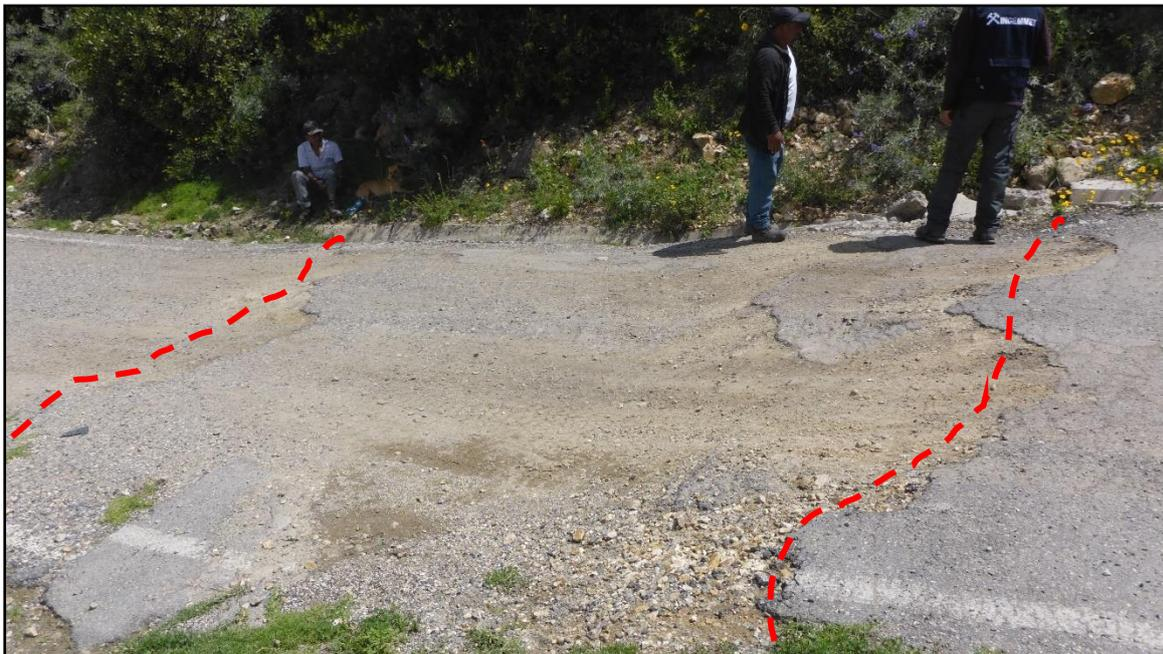
Figura 11. Agrietamientos N1, ubicado en la margen izquierda del deslizamiento, se evidencia en la ruptura de la calzada asfáltica.
