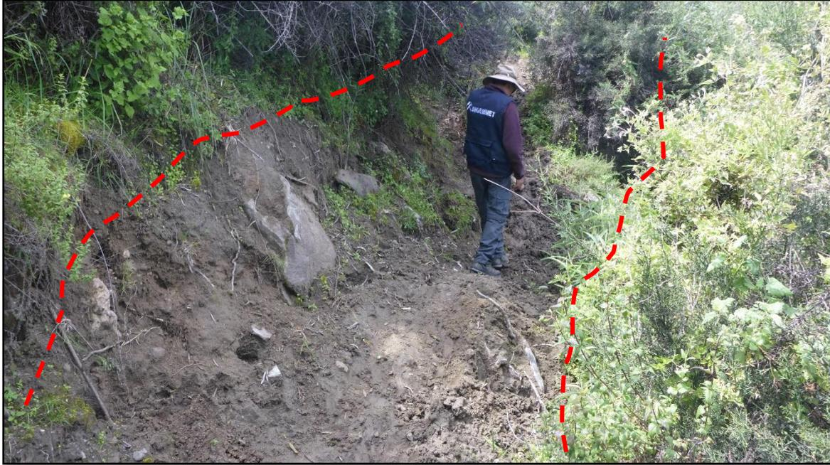
**Figura 12.** Agrietamientos N3, ubicado en la margen izquierda del deslizamiento, en la parte alta del anexo Pomacocha.
