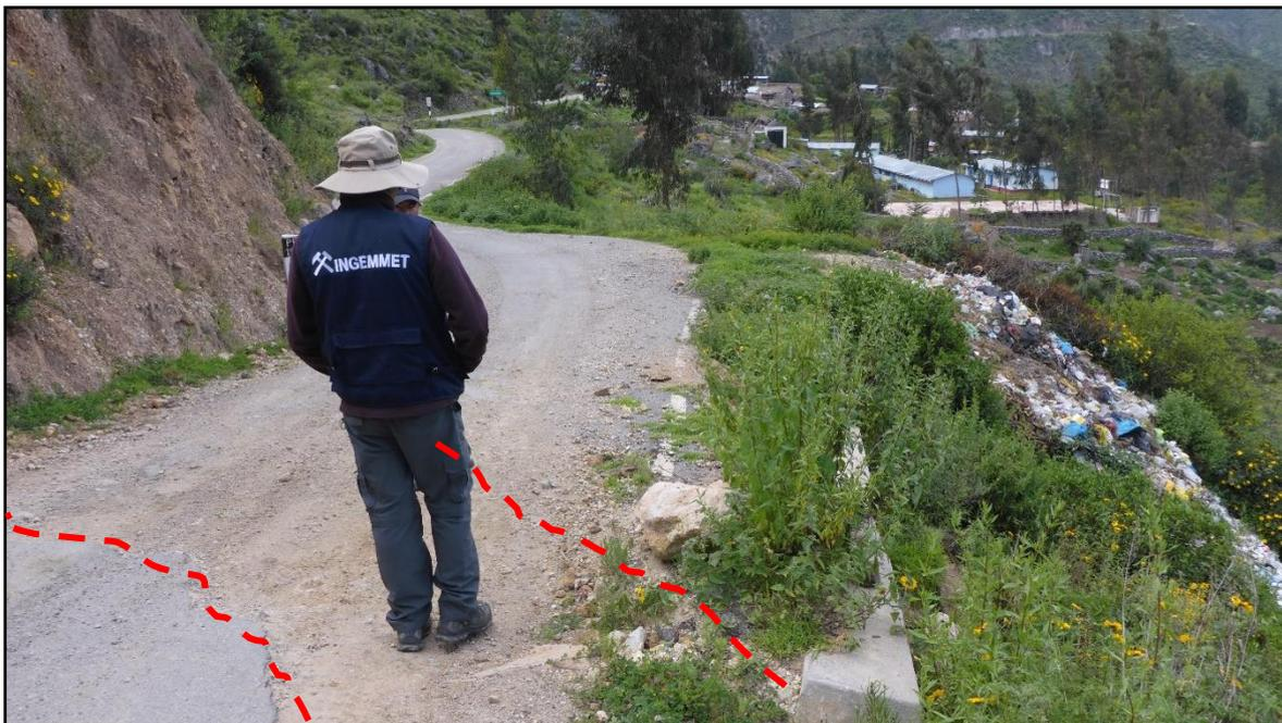
**Figura 14.** Agrietamientos N5, ubicado en la margen derecha del deslizamiento, antes de llegar al anexo Pomacocha.
