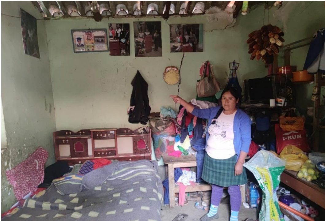
Fotografía 1. Grieta en el interior de una vivienda en el centro poblado Nunupata, producto de la deformación del terreno.
