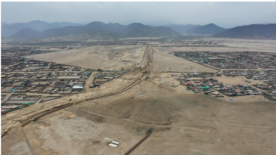
Fotografía 1. Imagen tomada por dron el año 2023, se observa la distribución poblacional en ambas márgenes de la quebrada Malanche asentadas sobre material arrastrados por flujos de lodo y detritos.
