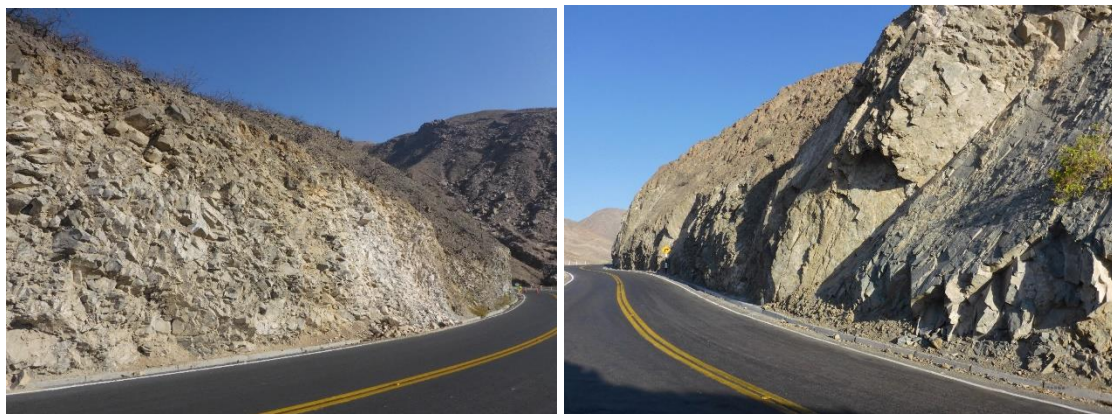
Figura 17. La Carretera Nasca-Abancay Km 21+800 y km 17, fueron afectada por caídas de rocas que generaron daños de hasta 300 m. Se podrían generar nuevamente procesos de derrumbes del terreno debido a movimientos sísmicos de moderada a fuerte intensidad, que puedan comprometer la carretera.
