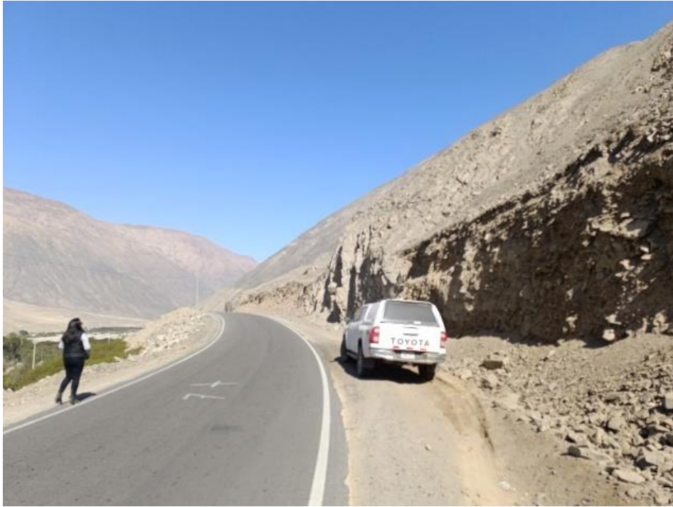
Fotografía 7. Tramo carretero Achanizo - Chaparra, sector Chacoma. Se observa un talud rocoso de intrusivo medianamente a muy fracturado. En el pie del talud se observa bloques sueltos, de hasta 0.5 m, los cuales cayeron y obstruyeron la vía por el sismo.
