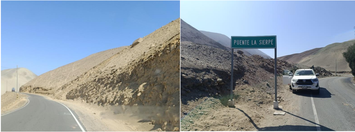
Figura 13. Tramo carretero puente La Sierpe hacia el desvío de la Panamericana Sur. Se observan niveles de conglomerados de compactación mediana a suelta que se desprendieron y obstruyeron la vía a lo largo de aproximadamente 4 km durante el sismo.
