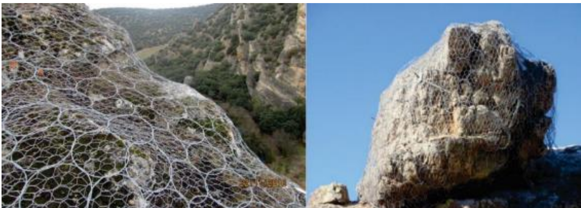
Figura 25. Ejemplos de estabilización con red de anillos
