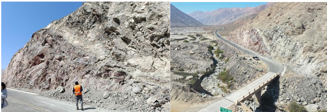
Figura 6. Sector tramo carretero Chala Viejo - La Pampa, altura del puente San Andrés. Se observa un talud rocoso poco fracturado a muy fracturado, conformado por andesitas, además
