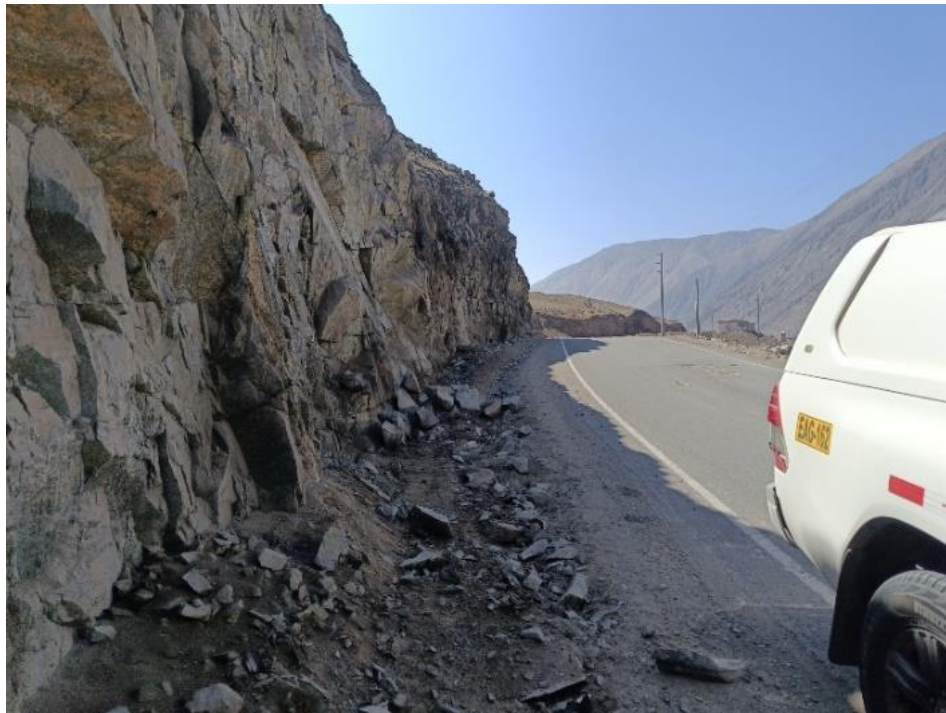
Fotografía 8. Sector tramo carretero Huancalpa – Achanizo, sector San Agustín. Se observa el talud rocoso muy fracturado, conformado por andesitas, además de bloques sueltos, angulosos, de hasta 0.5 m, los cuales cayeron y obstruyeron la vía por el sismo.
