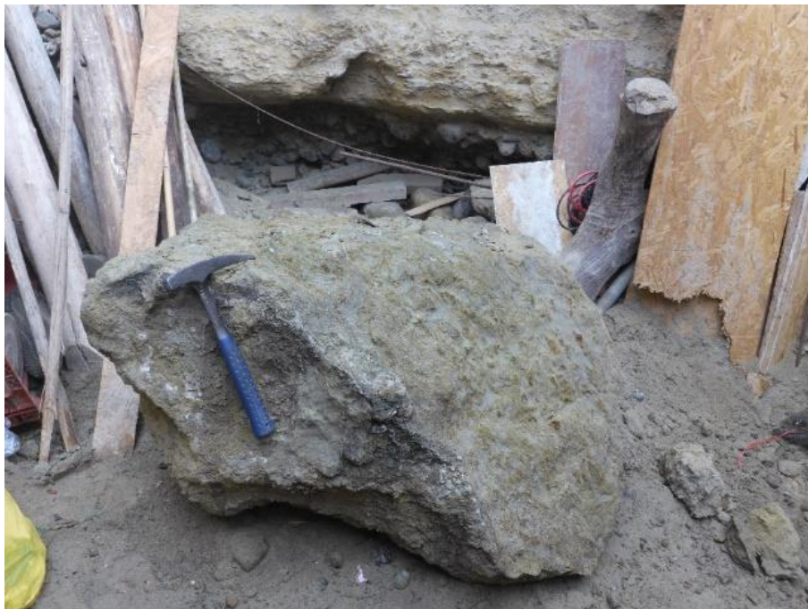
Fotografía 15. Procesos de caída de rocas que, afectó una vivienda y carretera Panamericana Sur. Bloques aislados de hasta 1.5 m de diámetro y mínimo de 0.5 m. Se podrían generar nuevamente estos procesos de caídas de rocas por movimientos sísmicos.
