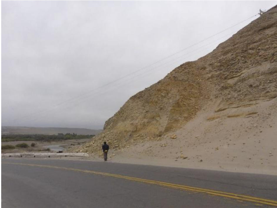
Fotografía 14. Puente Yauca-Chala, se generaron caída de rocas y derrumbes, provenientes de un conglomerado, afectó la carretera Panamericana Sur. Se podrían generar nuevamente de caídas de rocas.
