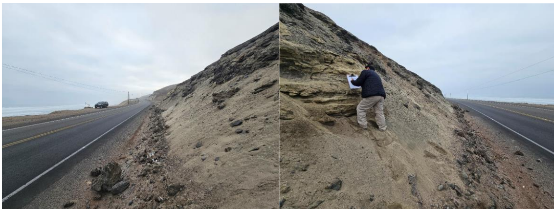
Figura 5. Carretera Panamericana – Chala-Atico. Se evidencian caída de rocas, bloques con diámetro de hasta 1 m, a raíz del sismo del 28 de junio del 2024.
