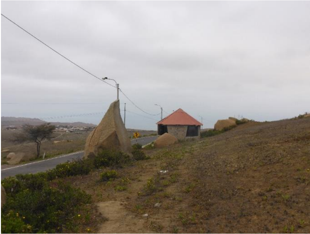
Fotografía 12. Procesos de caída de rocas antiguo en el sector de Atiquipa, con bloques de hasta 4 m. Se podrían generar nuevos eventos ante sismos.
