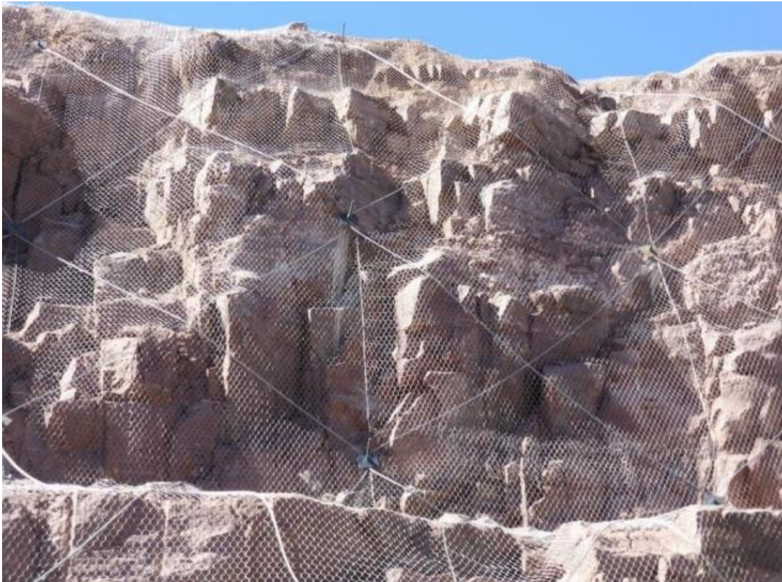
Figura 23. Control de caída de rocas utilizando mallas ancladas.
