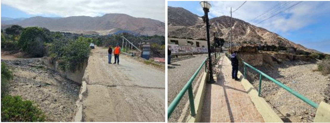
Figura 11. Puente antiguo y actual a Atico capital. No se evidenciaron facturas.
