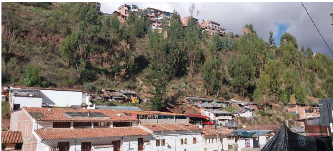
Fotografía 11: Pendiente muy fuertes a extremadamente fuerte, sector margen derecha de la quebrada Saphy. Fuente: Equipo técnico.
