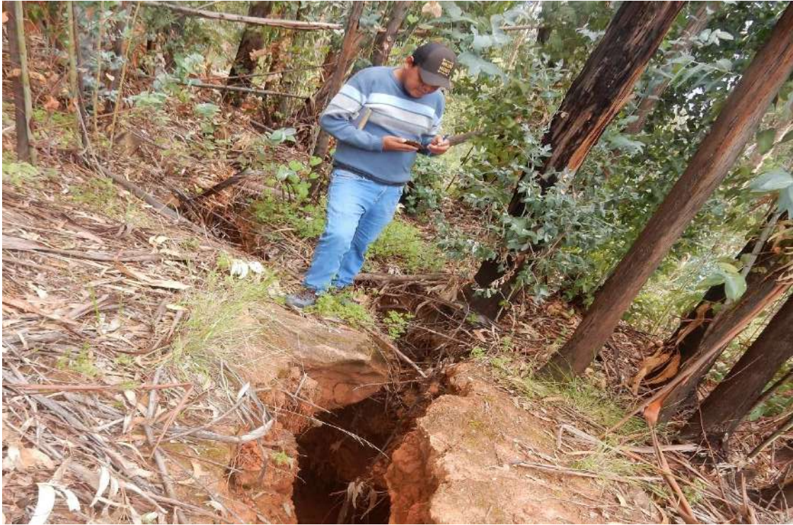
Fotografía 03. Grietas en la parte alta del ámbito de estudio
