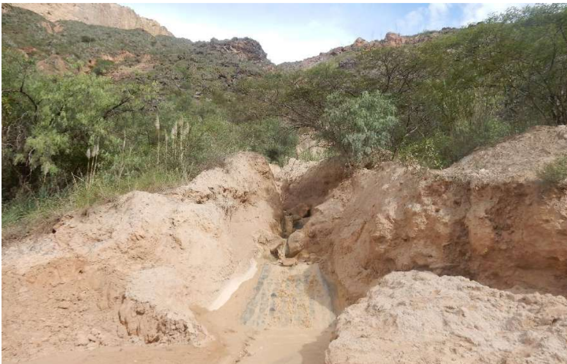
Fotografía 06. Evidencia de flujo de detritos que podrían afectar la vía distrital
