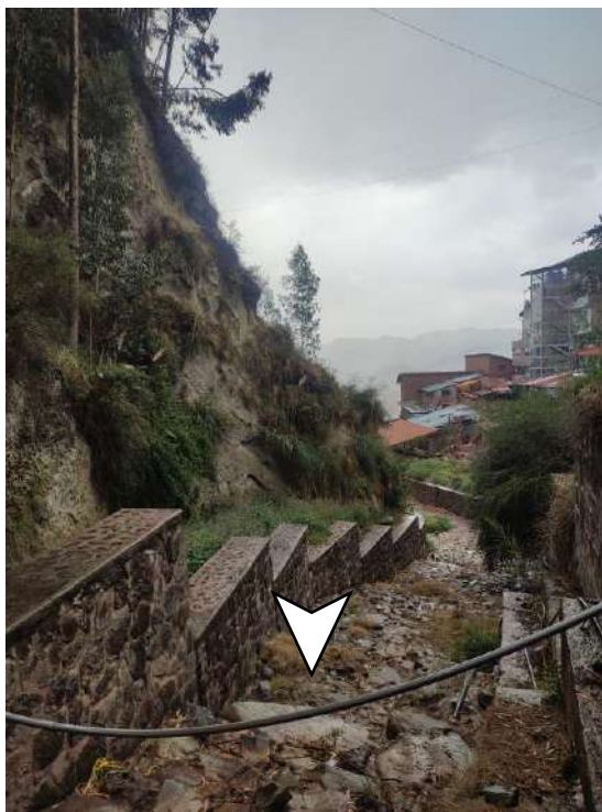
Fotografía 4: Terreno con pendiente entre 20° a 35° Fuente: Fotografía propia.
