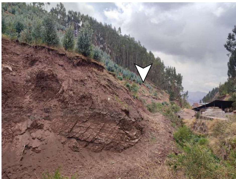
Fotografía 18: Terreno con pendientes mayores a 35°, se puede observar en mayor porcentaje en las laderas. Fuente: Fotografía propia.
