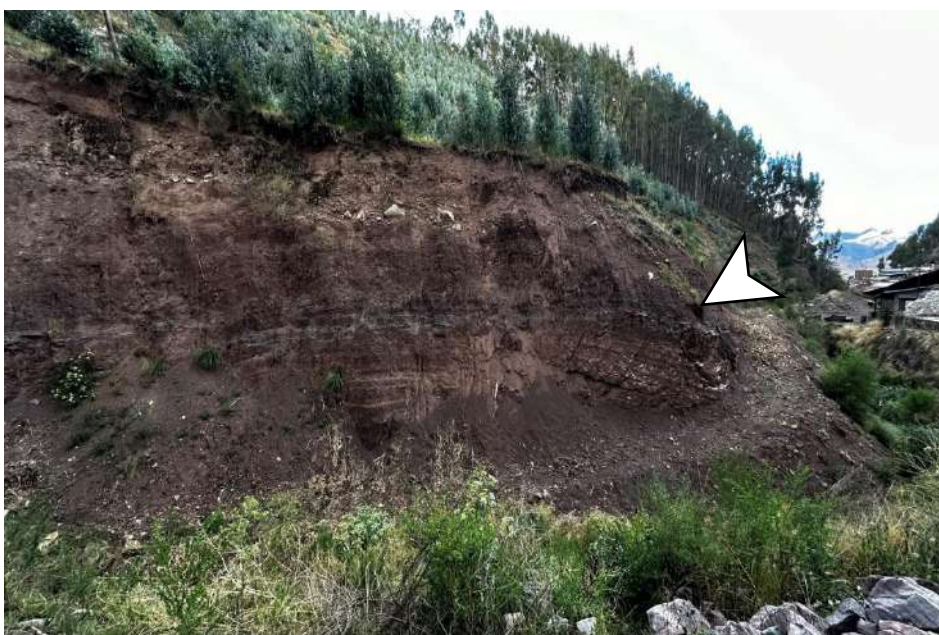
Fotografía 12: intercalación de lutitas pardas y negras Fuente: Fotografía propia
