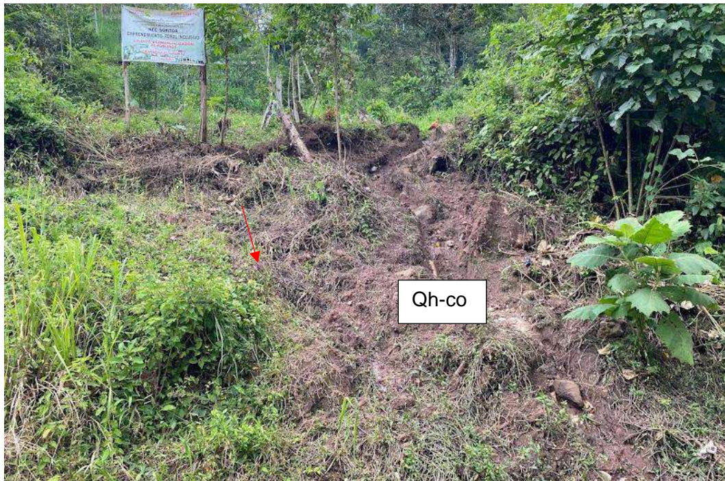
Foto N°7. Depósitos coluviales producto de deslizamientos de suelos.
