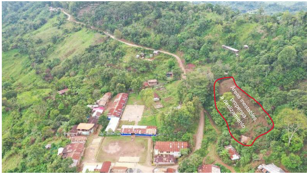
Foto N° 9. Área de deslizamiento producto de la deforestación.
