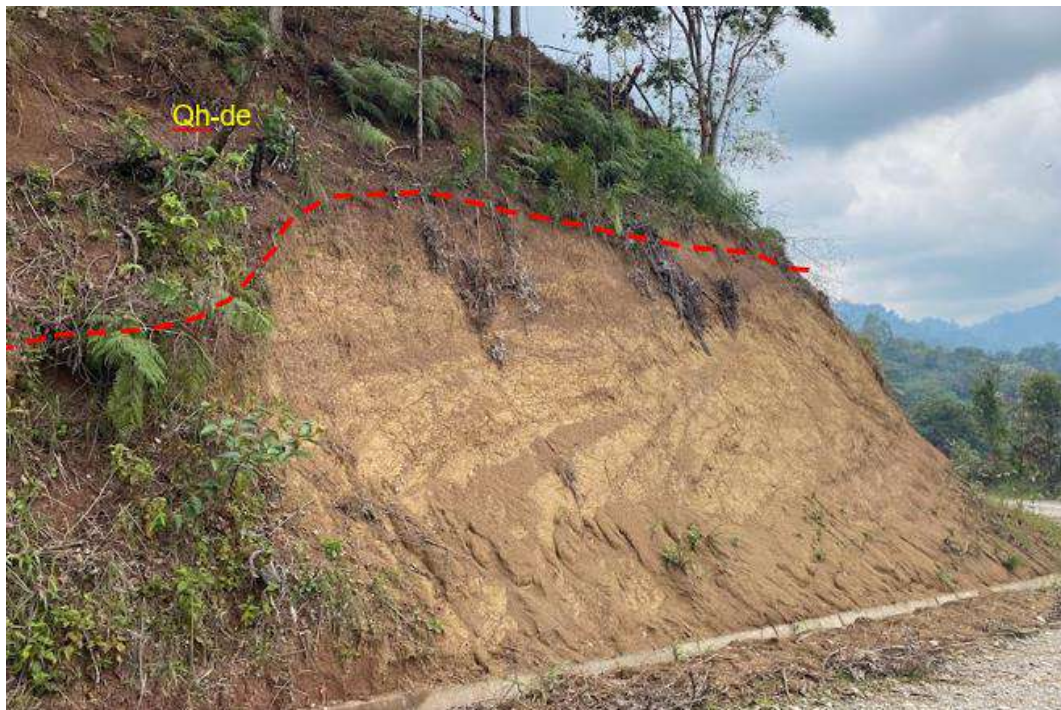
Foto N°6. Depósitos deluviales cubriendo areniscas.
