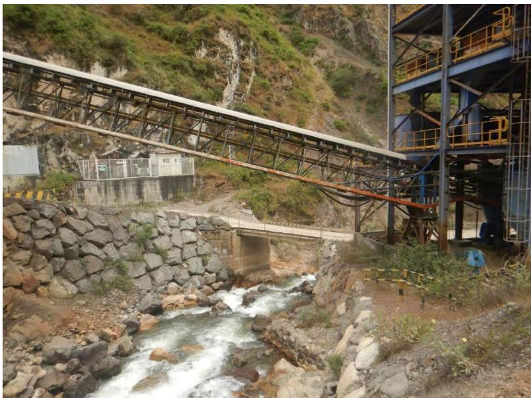
**Fotografía 7.** Se observa la Unidad de Chancado y Molienda, dispuesta a solo 2.0 m, del cauce principal del río Parac. Esta construcción minera es susceptible a la ocurrencia de flujos de detritos.
