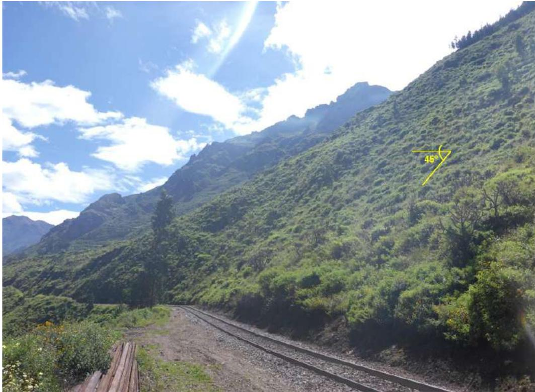
**Figura 18.** Pendiente del terreno de hasta 45° en el depósito del deslizamiento antiguo. Vista hacia el noreste, ubicada en una margen de la vía férrea.
