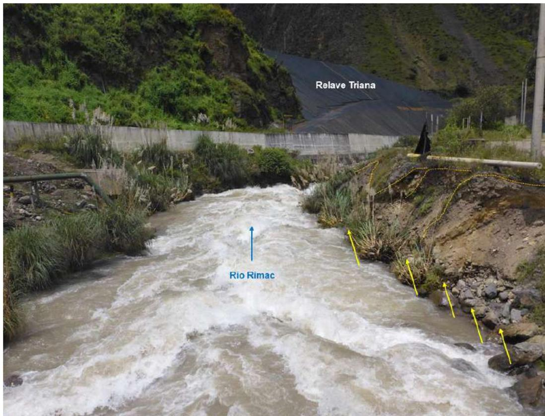
**Figura 25.** Erosión fluvial en la margen derecha del río Rímac (flechas amarillas) que genera pequeños derrumbes (líneas discontinuas anaranjadas). Vista aguas abajo.
