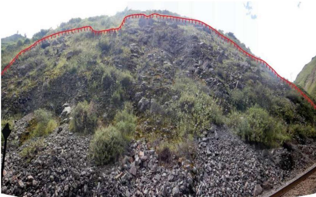
**Figura 22.** Procesos de caída de rocas a un costado de la línea férrea, entre las coordenadas UTM N 8696681, E 358054 con una cota de 3085 m s.n.m. La línea roja corresponde a la zona de arranque de los procesos en mención.
