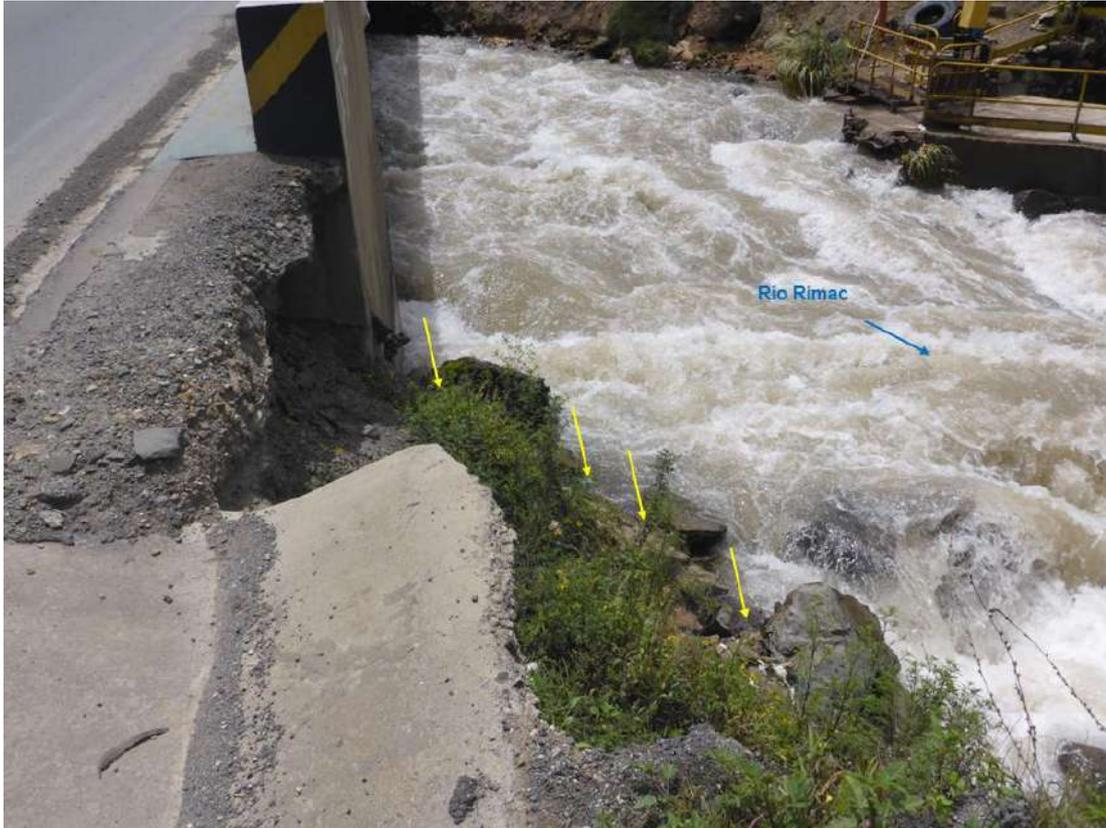
**Figura 26.** Erosión fluvial en el estribo derecho del puente ubicado a la altura de la entrada a la Unidad Minera Coricancha (flechas amarillas). Vista aguas abajo.
