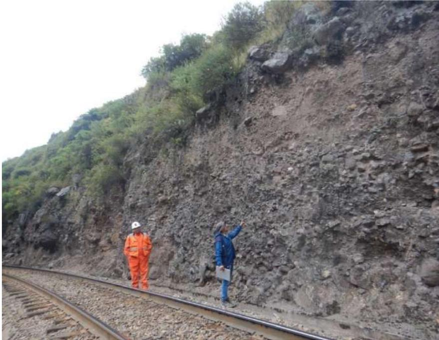
**Fotografía 1.** Depósito coluvio-deluvial identificado a un lado de la vía ferrea, donde se observan bloques y gravas de naturaleza volcánica angulosas a subangulosas envueltas en una matriz limosa
