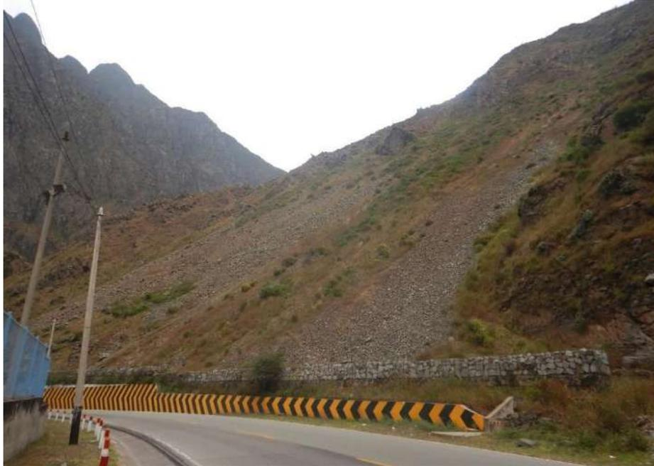
**Fotografía 3.** Depósitos coluviales inconsolidados generados por caídas de rocas en la margen derecha del río Rímac, frente a la represa.
