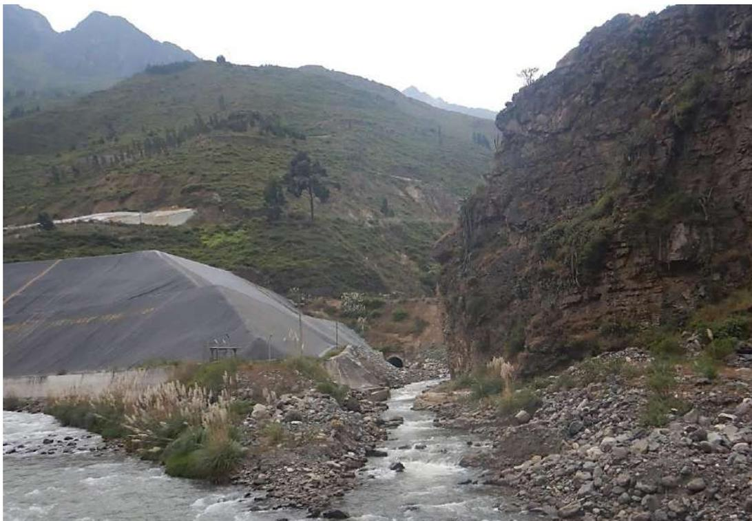
**Fotografía 8.** Se observa la alcantarilla con capacidad limitada para el paso de un eventual flujo de detritos en la quebrada Parac; lo que condicionaría su colmatación, un embalse aguas arriba y una posterior rotura del dique sobre el que se encuentra la vía del ferrocarril central.
