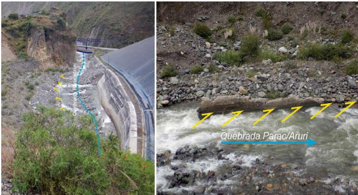
**Figura 27.** Erosión fluvial en la margen izquierda de ladera en la quebrada Parac/Aruri.
