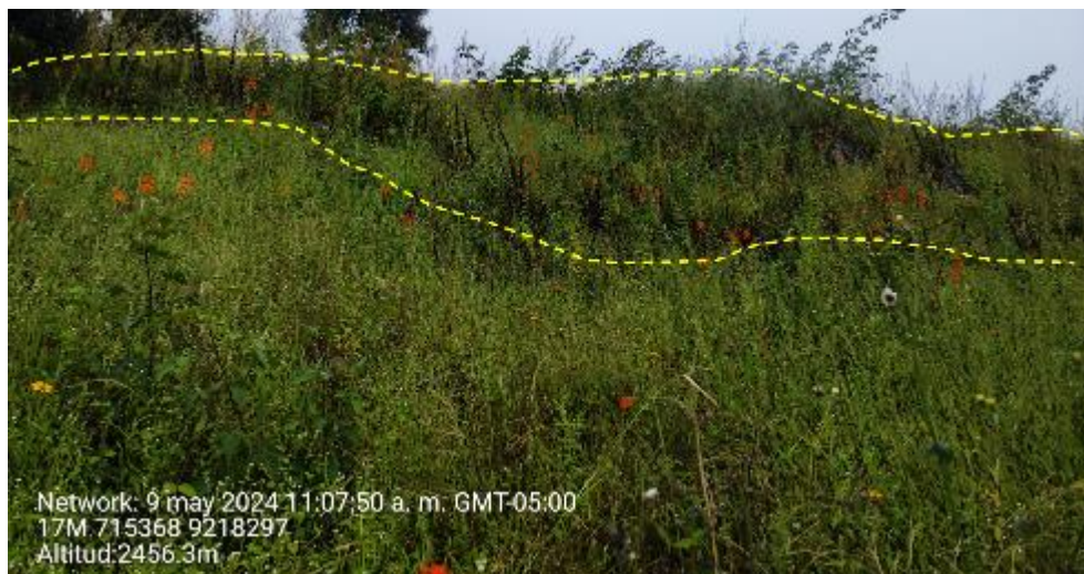
Figura 11. Escarpe principal del deslizamiento con salto vertical de hasta 1.5 m.
