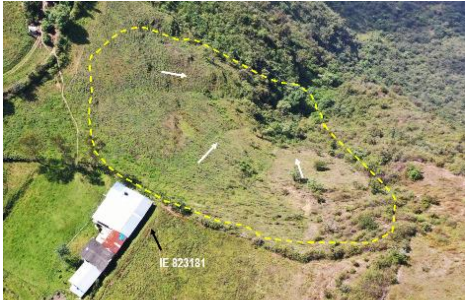
Figura 15. Vista de la zona influencia del deslizamiento inactivo latente de La Pauca y su proximidad a la IE 823181.
