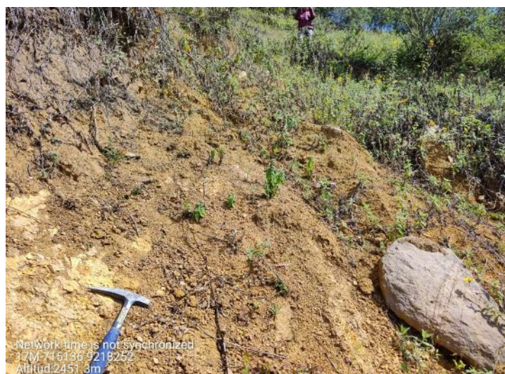
Fotografía 5. Superficie de deslizamiento visto al este del deslizamiento rotacional inactivo latente. Ubicación: E: 715136; N: 9218252, Z: 2451
