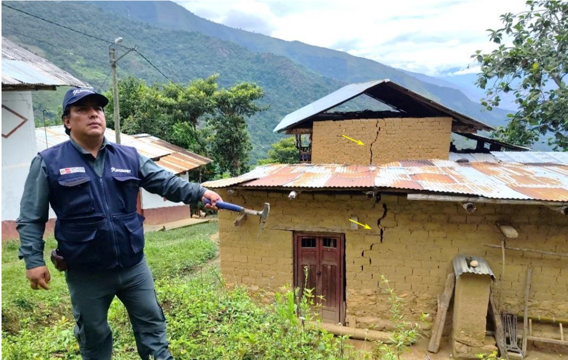
Figura 9. Pared de vivienda, presenta grietas de longitud 1.5 m y ancho de 1 a 7 cm; producto de la reptación. Coordenadas UTM WGS84 17M. 777468, 9334817.
