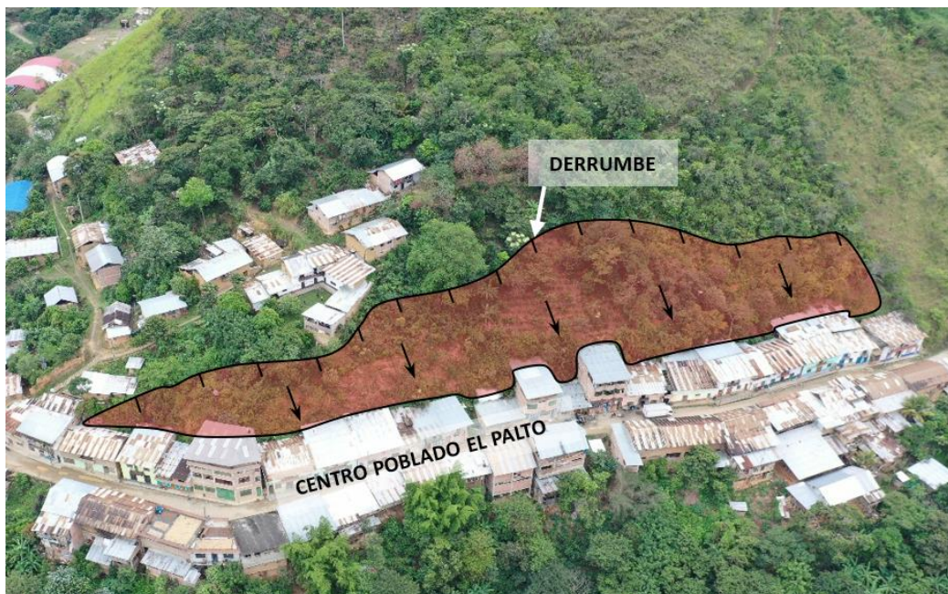
Figura 2. Derrumbe ubicado sobre viviendas del centro poblado El Palto.
