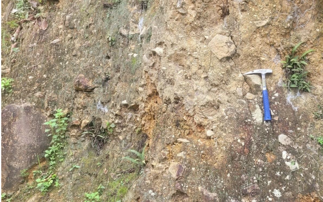
Figura 3. Depósito coluvio-deluvial (corte de talud para construcción de vivienda).
