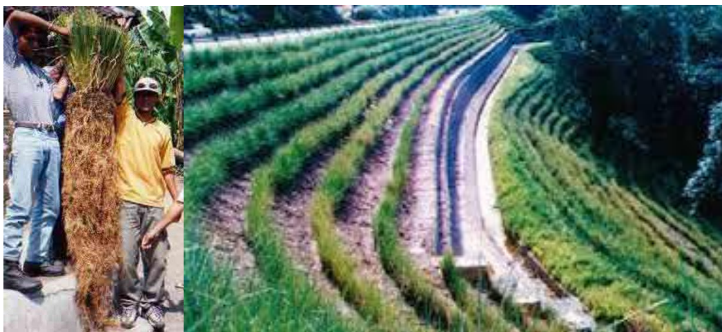
Fotografía 3. Ejemplo de bioingeniería con arbusto (vetiver) en taludes de materiales sueltos.
