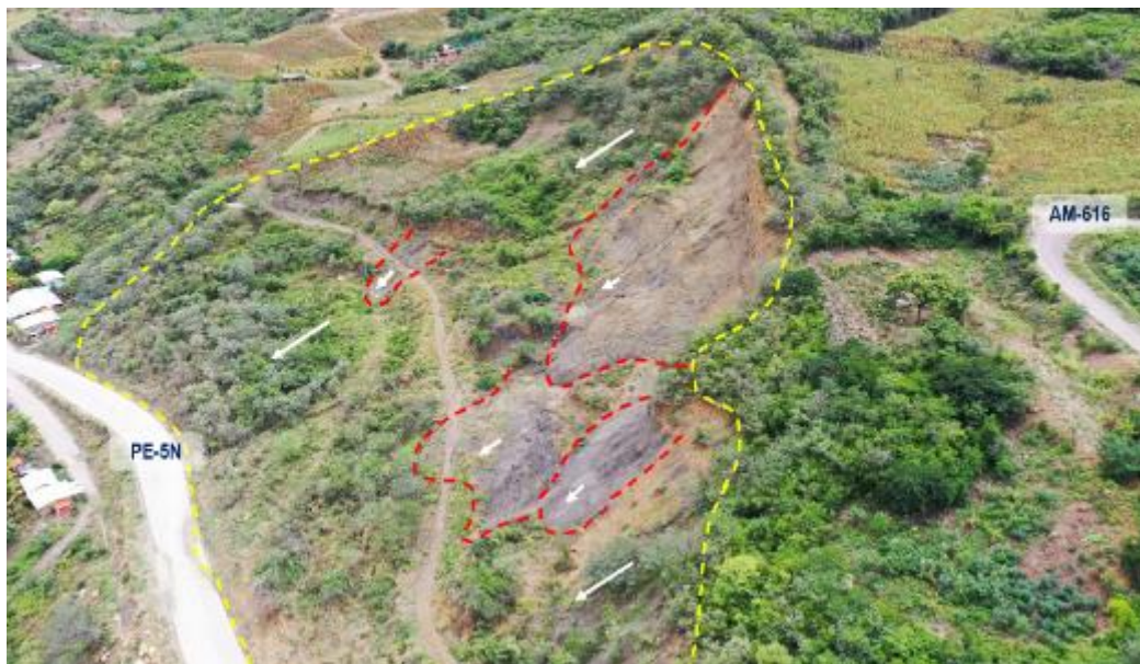
Figura 15. Estado del deslizamiento D-2 en abril del 2024, el cuerpo del deslizamiento está delimitado en línea amarilla, los flujos no canalizados están delimitados en línea roja.
