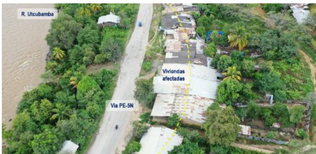
Figura 17. Estado del deslizamiento D-5 en la localidad de Salao en abril del 2024, la corona del deslizamiento está marcada en línea amarilla.
