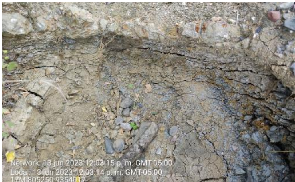
Fotografía 2. Macizo rocoso de lutitas calcáreas y calizas arenosas muy fracturadas y altamente meteorizadas de la Formación Celendín en la localidad de Salao. Ubicación: E: 805250, N: 9354017.
