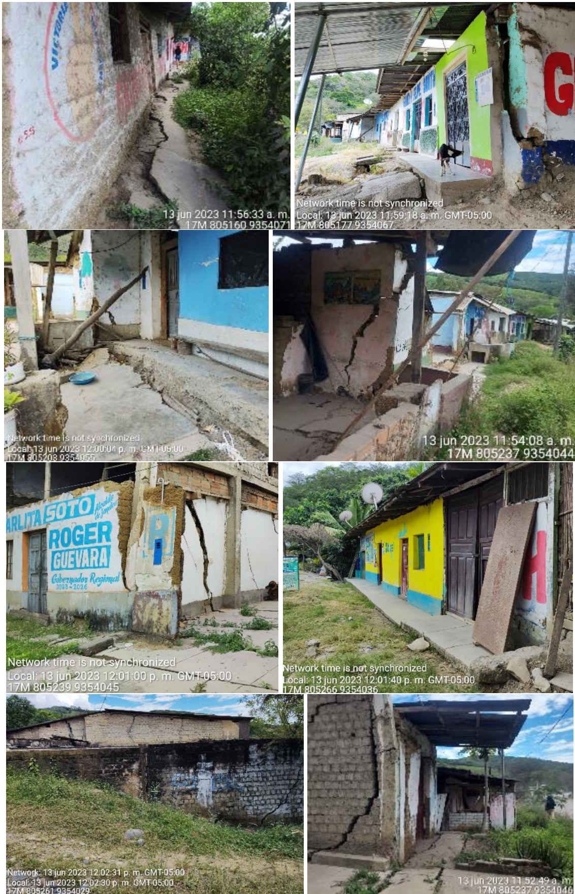
Fotografía 4. Diferentes viviendas inhabitables producto del deslizamiento D-5 en la localidad de Salao.
