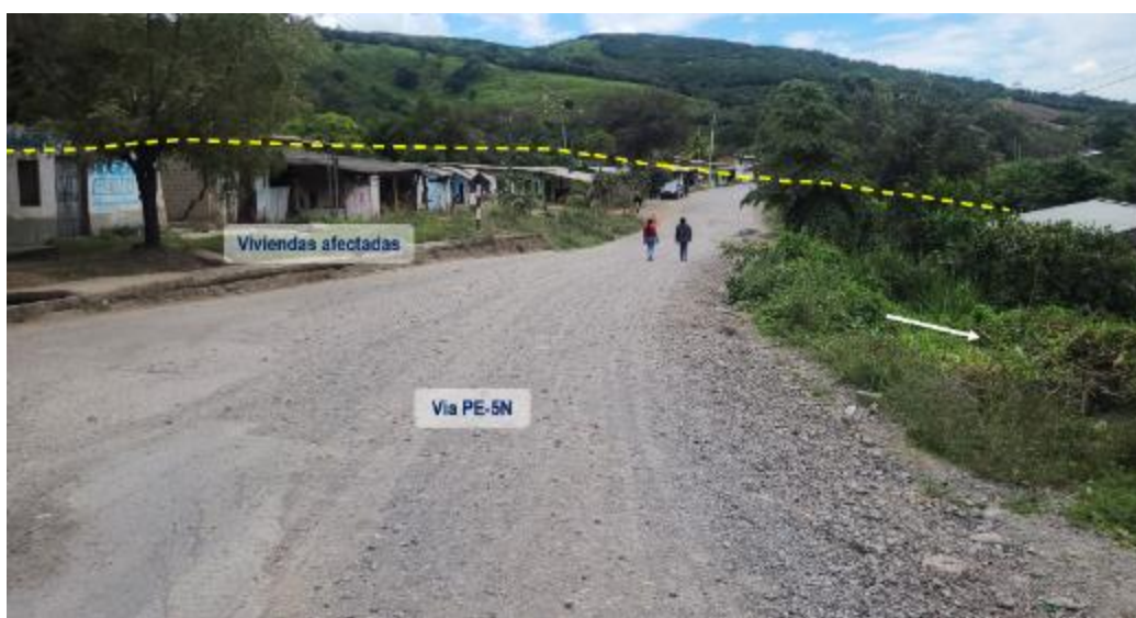
Figura 18. Vista del sector afectado por el deslizamiento D-5 en junio del 2023. Ubicación: E: 805267; N: 9354043. En línea amarilla se aprecia el límite del margen derecho del deslizamiento.
