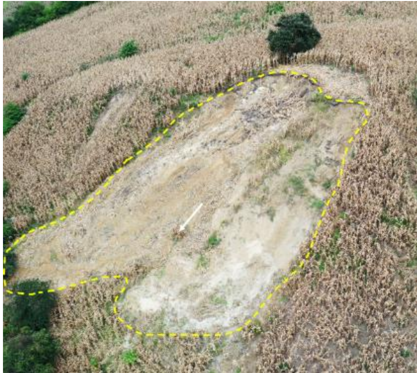
Figura 21. Deslizamiento D-6 ubicado en la parte alta de la localidad de Salao.
