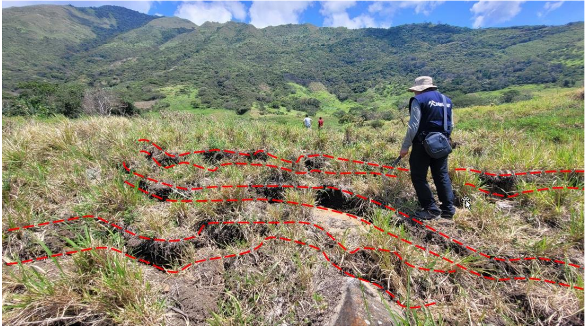
Figura 13. Agrietamientos en el cuerpo del deslizamiento, con longitudes de 5 a 15 m y apertura entre 10 y 20 cm.
