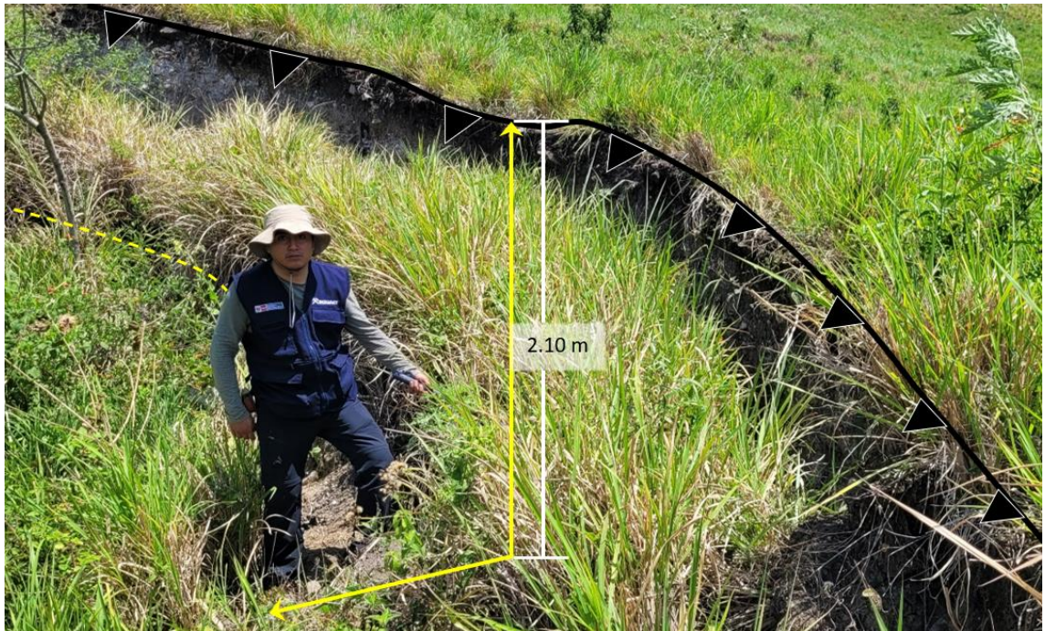
Figura 7. Vista del escarpe principal, altura de 2.10 m. (Coordenadas UTM WS-84 -17S, Norte: 9336472– Este: 734077).
