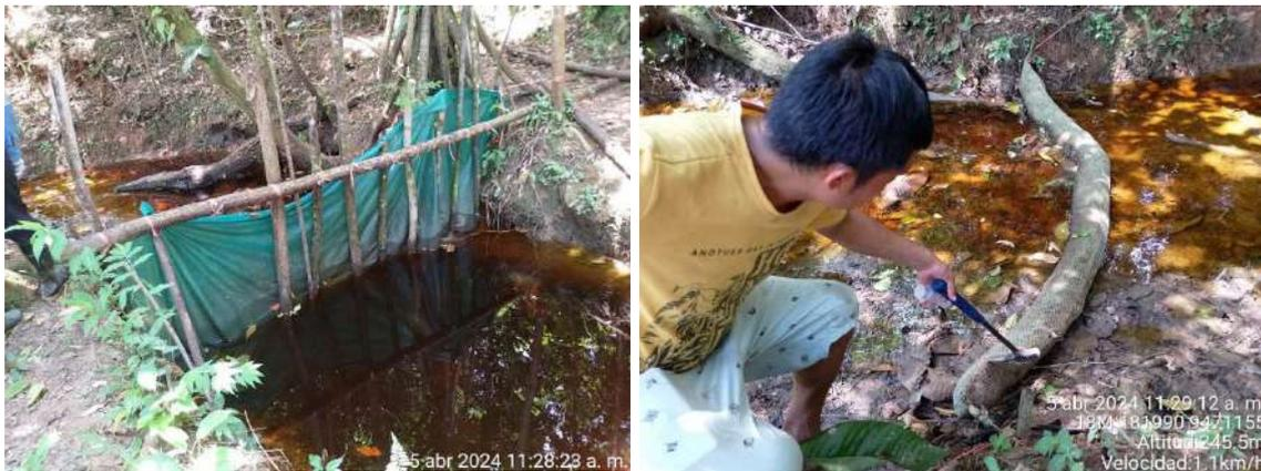
**Figura 7.10.** A) Barrera artesanal de control de migración de crudo en la quebrada Quebrada Numpatkain (UTM WGS84: 18M: 182208E, 9471344N). B) Quebrada Numpatkain (UTM WGS84: 18M: 182208E, 9471344N), otro tipo de barrera que impida fluir río abajo el petróleo.
