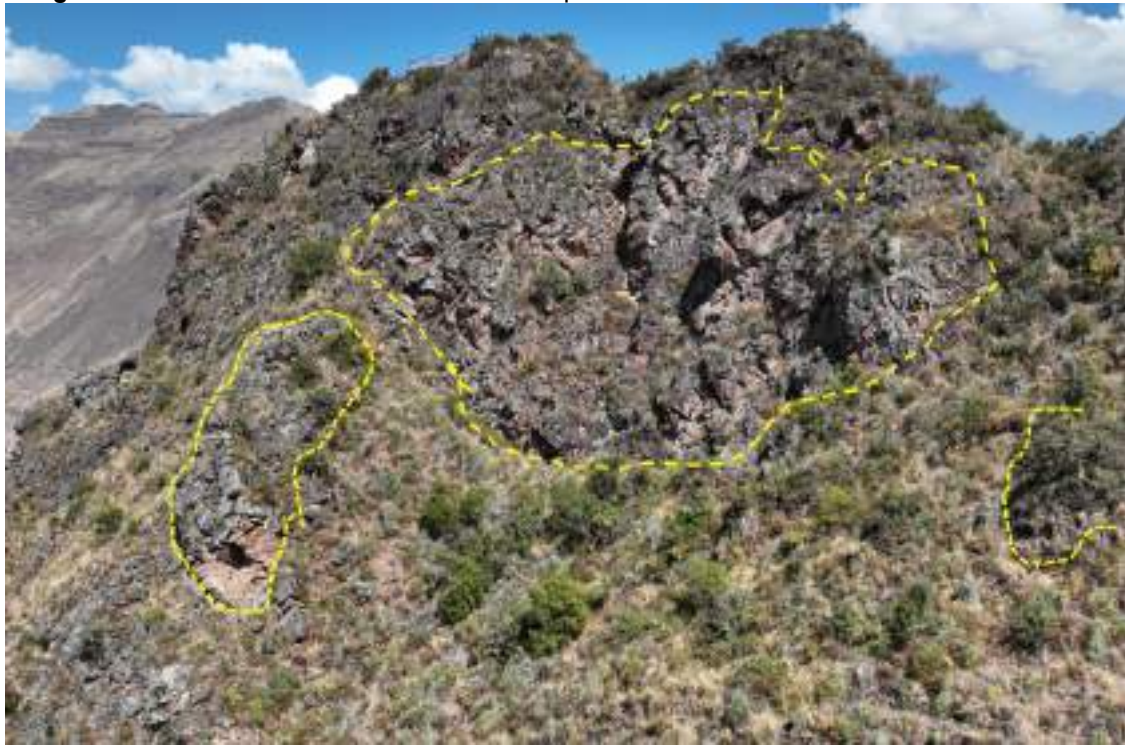
Figura 75. Macizos rocosos fracturados con posible rotura en vuelco.
