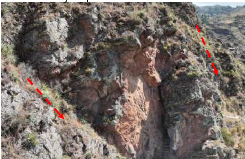
Figura 30. Pendiente muy escarpado, túnel 1.
