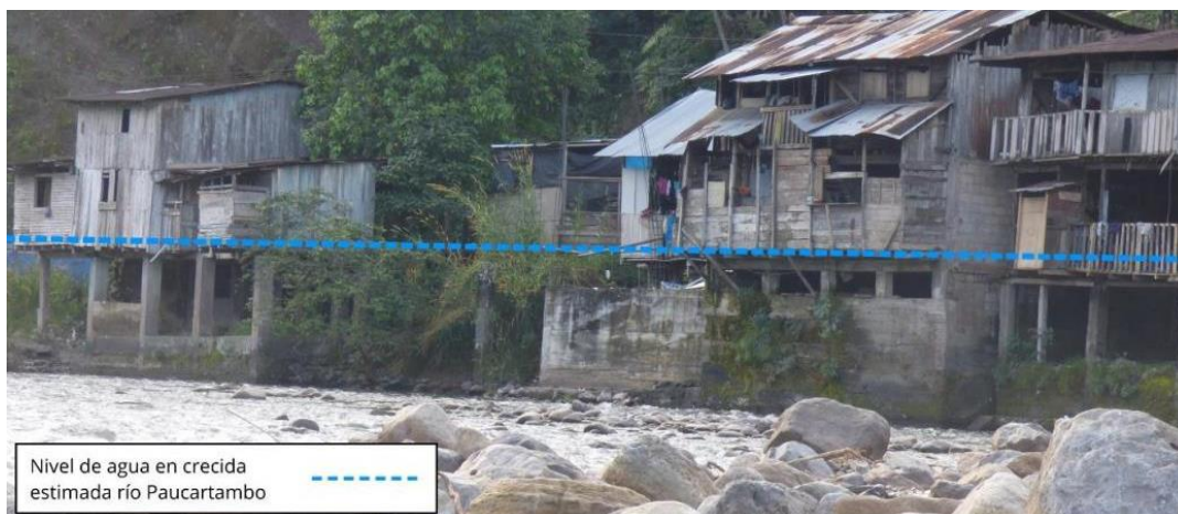
Figura 7. Viviendas expuestas a inundación y erosión fluvial, construidas precariamente en la margen izquierda del río Paucartambo. Tomado de Núñez & Albinez 2018. Las viviendas de la imagen fueron destruidas por la crecida del 2019.
