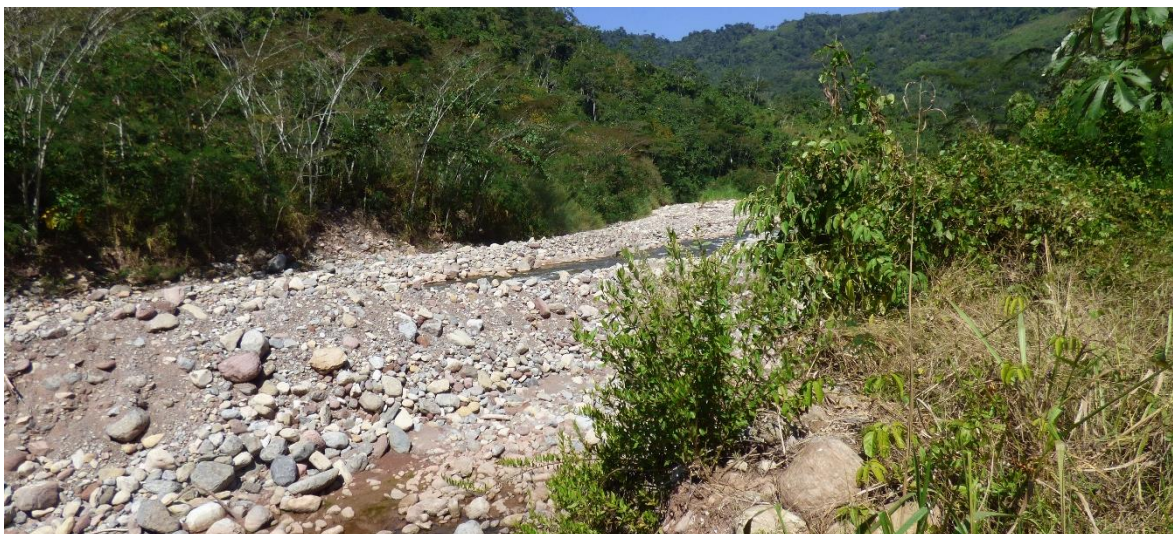
Fotografía 2. Imagen del río Entás, su cauce se encuentra colmatado.
