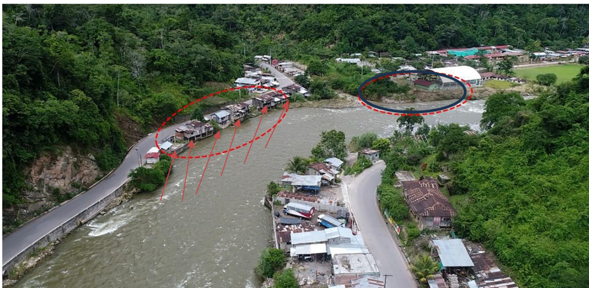
Figura 5. Viviendas expuestas a inundación y erosión fluvial (sin defensa ribereña alguna), construidas precariamente en la margen izquierda del río Paucartambo y centro deportivo del sector San Martín. Foto INDECI – Villa Rica. Se observan resaltadas viviendas destruidas en el 2009.
