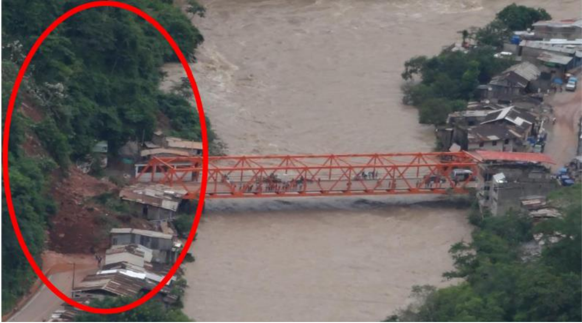
Figura 11. Imagen del deslizamiento ocurrido el año 2014. Se observa afectación de viviendas y el estribo sur del Puente Paucartambo. Foto INDECI - Villa Rica.
