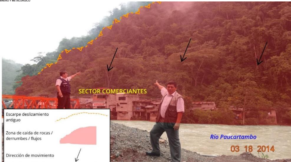
Figura 9. Morfología de deslizamiento antiguo en el Sector Comerciantes, Puente Paucartambo, en este sector hay ocurrencia de caída de rocas. Foto INDECI - Villa Rica.
