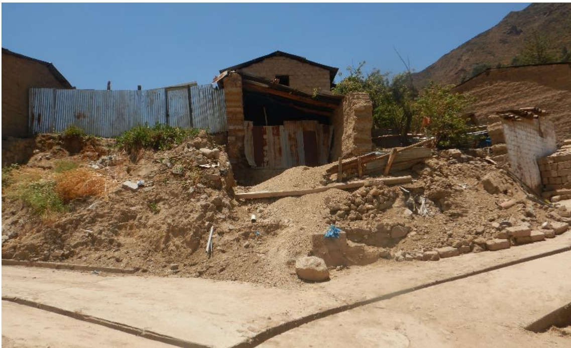
Fotografía 4. Vista de vivienda de adobe colapsada, ubicada entre el pasaje Petit Thours con calle Los Suspiros. Coordenadas referenciales UTM WGS-84, 18S: E: 502523; N: 8454468.
