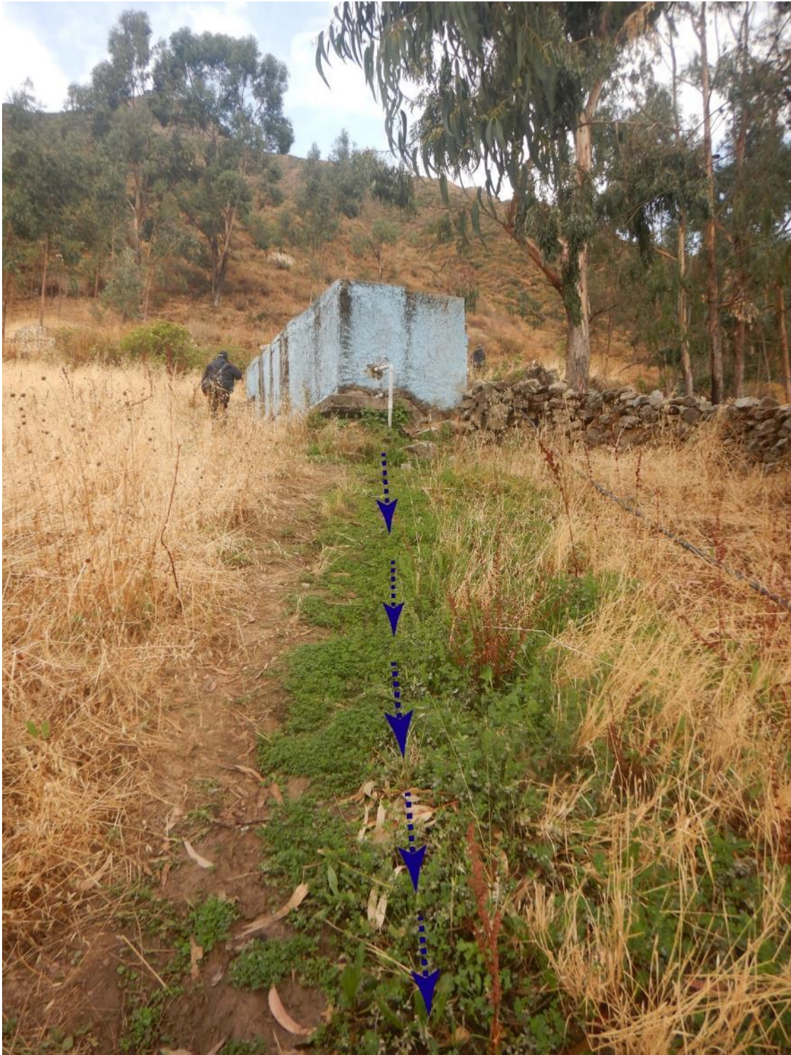
Figura 20. Vista de una captación de agua (reservorio de agua), el cual se pudo observar que parte del agua discurre por la ladera (flechas entrecortadas azules), llegando a infiltrarse pendiente abajo sobre el terreno (distinguido por el terreno húmedo) en dirección hacia las calles principales. Coordenadas referenciales UTM WGS-84, 18S: E: 502737; N: 8454793.
