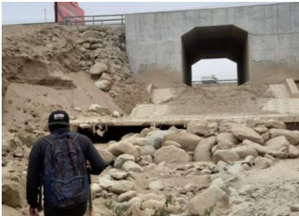
*Figura 57. Visualización de la presencia de socavación en estructuras hidráulicas (puente), dentro del lecho natural de la Quebrada Malanche – Punta Hermosa.*
