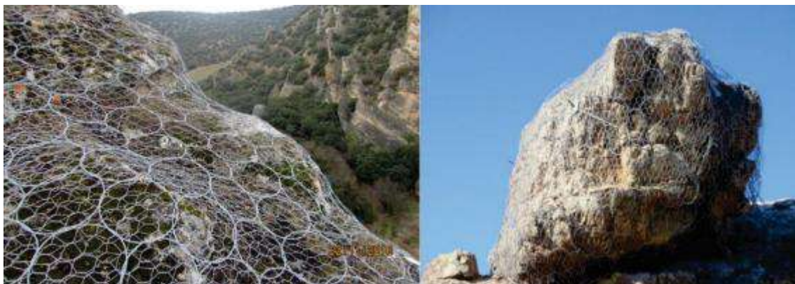
Figura 31. Ejemplos de estabilización con red de anillos
