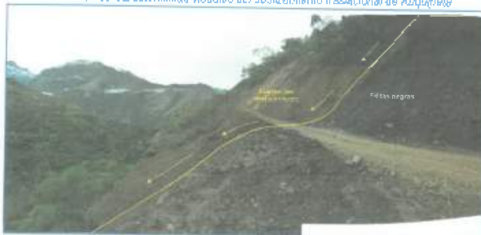
Ilustración 50 Características visuales del deslizamiento traslacional de Kuquipata
