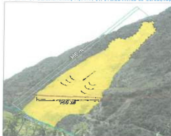
Franja. Vista de la reactivación del deslizamiento de Curcuchaca, cuyo escarpa de forma discontinuo-elongado, presenta 180 m de longitud.
