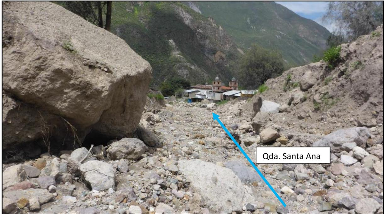
**Figura 18.** Cauce de la quebrada Santa Ana, el cual fue profundizado y ensanchado.
