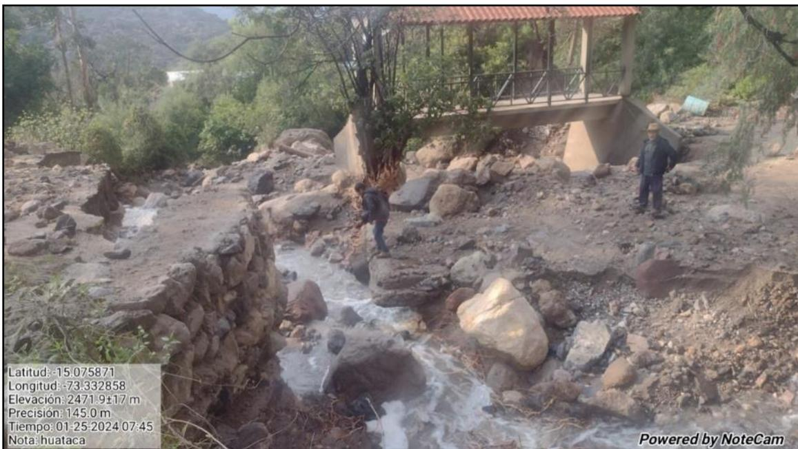
**Figura 12.** Afectación del puente Huataca, ocasionado por el flujo de detritos del 24 de enero del presente año. Fotografía: Municipalidad distrital de Marcabamba.
