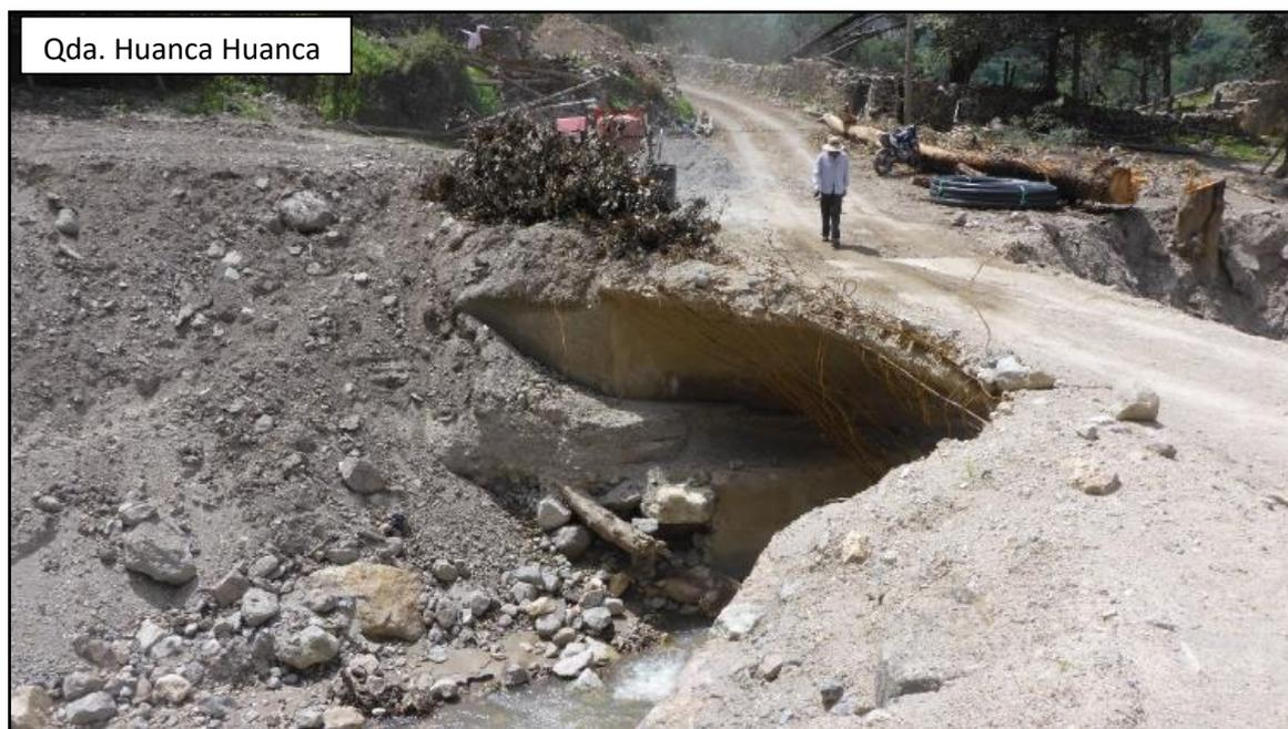
**Figura 24.** Puente y vías afectados por el flujo que descendió por la quebrada Huanca Huanca.
