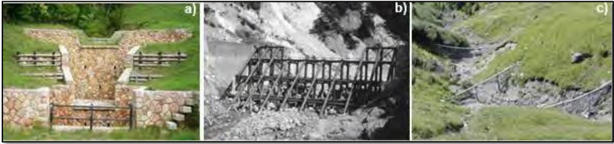
**Figura 26.** Presas tipo SABO de sedimentación escalonada para controlar la fuerza destructiva de los huaicos, a) de control; b) tipo rejilla; c) barras flexibles, (Vilches, 2021)
