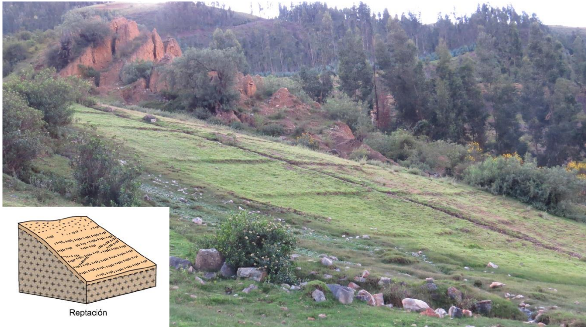
Figura 10. Vista del terreno que esta reptando.
