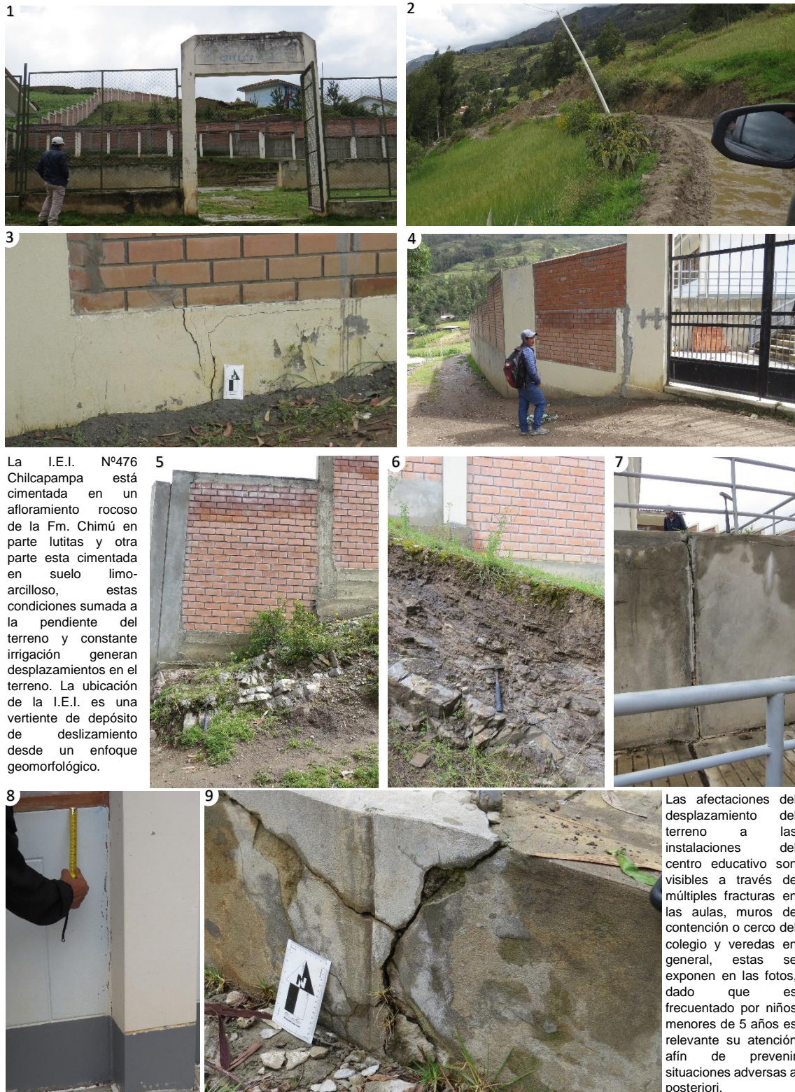
Figura 13. Panel de fotografías: 1. Vista panorámica de la I.E.I. N°476 Chilcapampa. 2. Poste de alumbrado eléctrico inclinado, evidencia del movimiento. 3. Grietas en la base de los muros. 4. Muros de la puerta resanados ante el colapso de la puerta. 5. Muros cimentados sobre areniscas grises. 6. Cerco de muros cimentados en lutitas negras. 7. Muro agrietado de la I.E.I. 8. Muro y columna divididas por grietas en las paredes de las aulas de los niños menores. 9. Veredas agrietadas con aberturas de 1cm.
