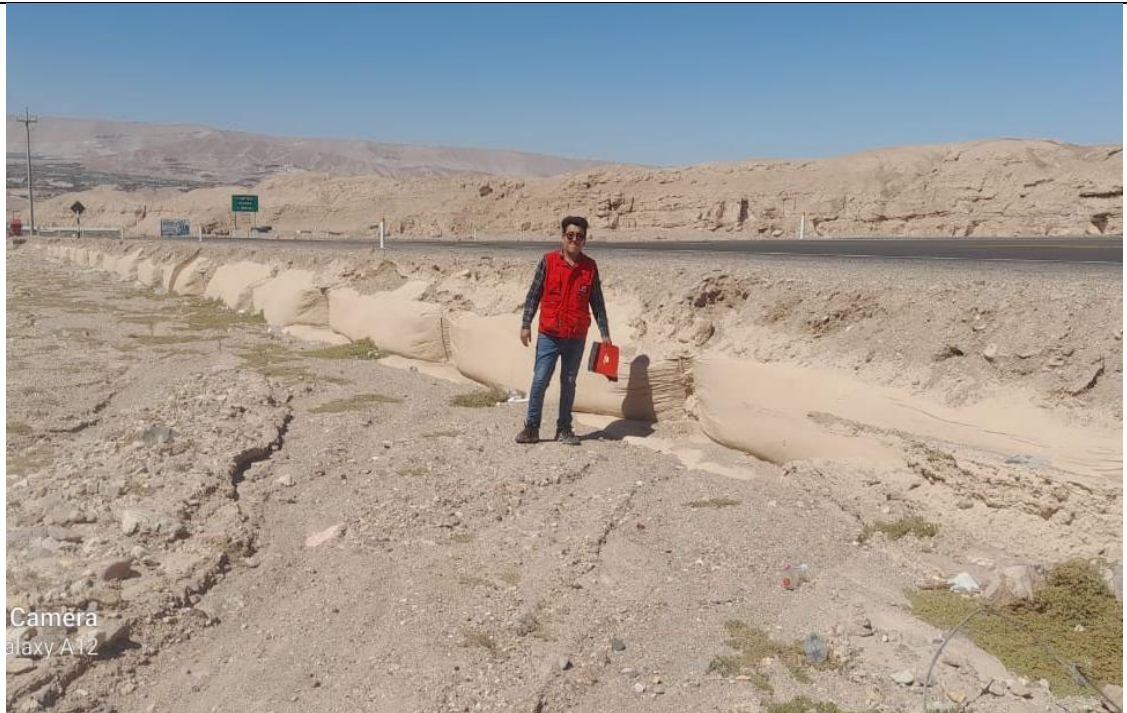
Vista de medidas de mitigación de riesgo con sacos de lona al costado de la carretera Panamericana.
