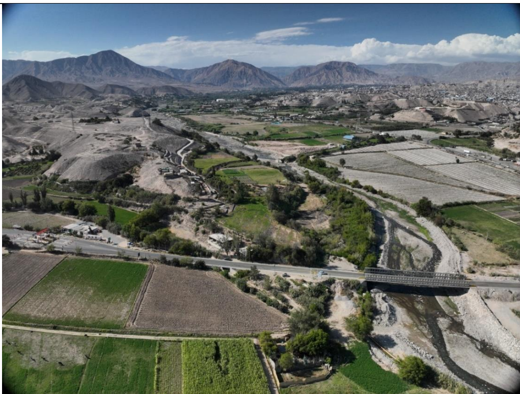
Vista de la quebrada Mono en su afluencia al río Moquegua, colindante al puente Montalvo
