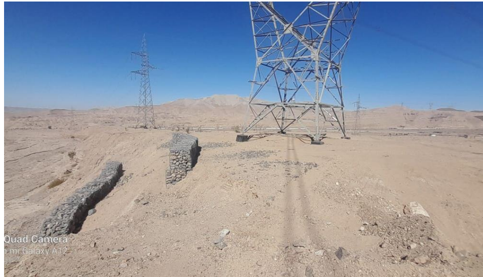
FOTO 8: Vista de las antenas eléctricas próximas al talud de la quebrada con medidas estructurales preventivas de gaviones en ladera.
