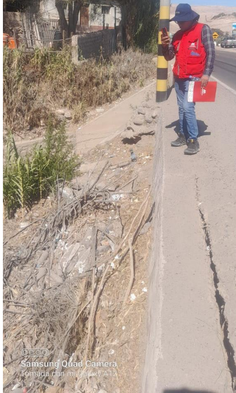
FOTO 10: Muro de contención próximo al peaje Montalvo.
