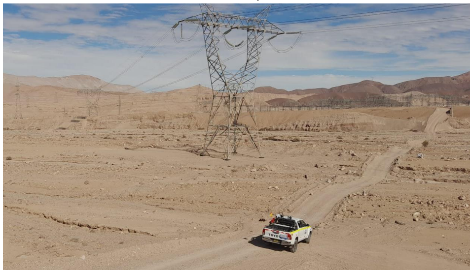
FOTO 7: Vista de las antenas eléctricas en el cauce de la quebrada sin medidas estructurales preventivas.
