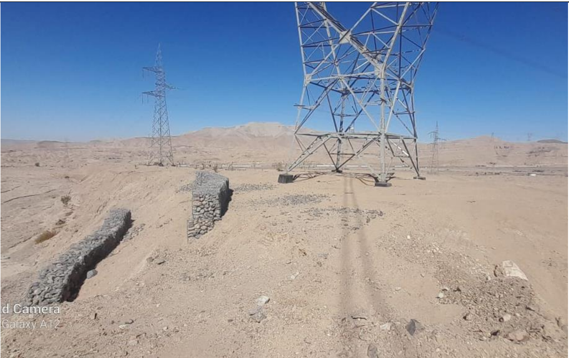
Vista de medidas estructurales con muros de gaviones en forma escalonada, próximos a las torres de alta tensión.
