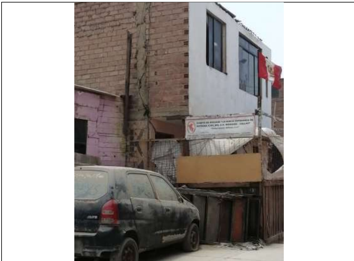
Viviendas precarias de vulnerabilidad muy alta
