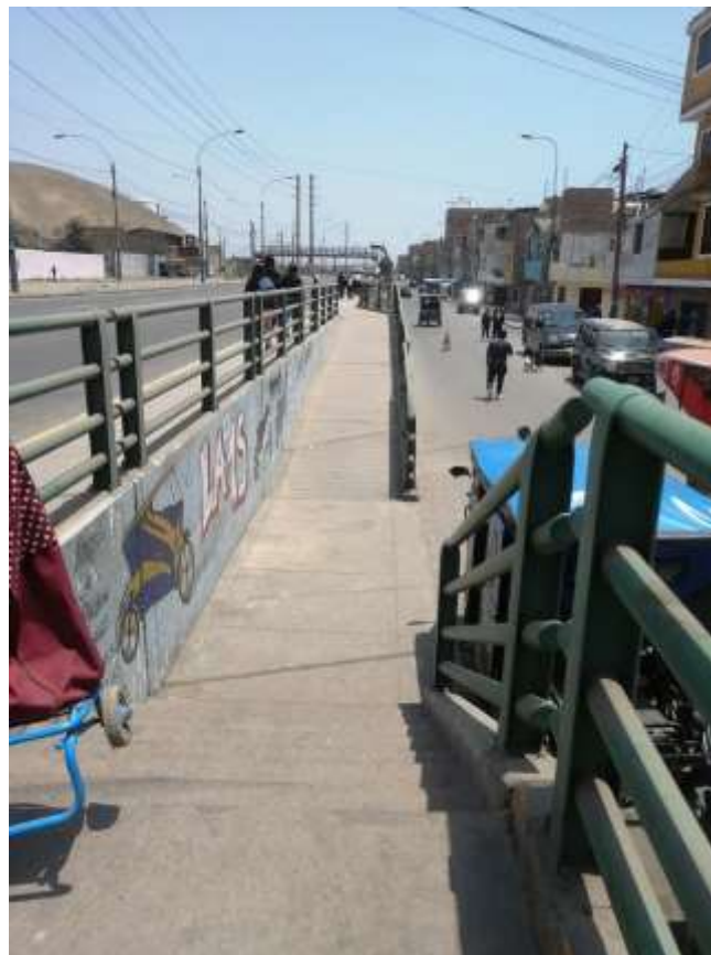
Rampas de acceso a la Av. Nestor Gambetta, zonas de evacuación ante ocurrencia de tsunami.
