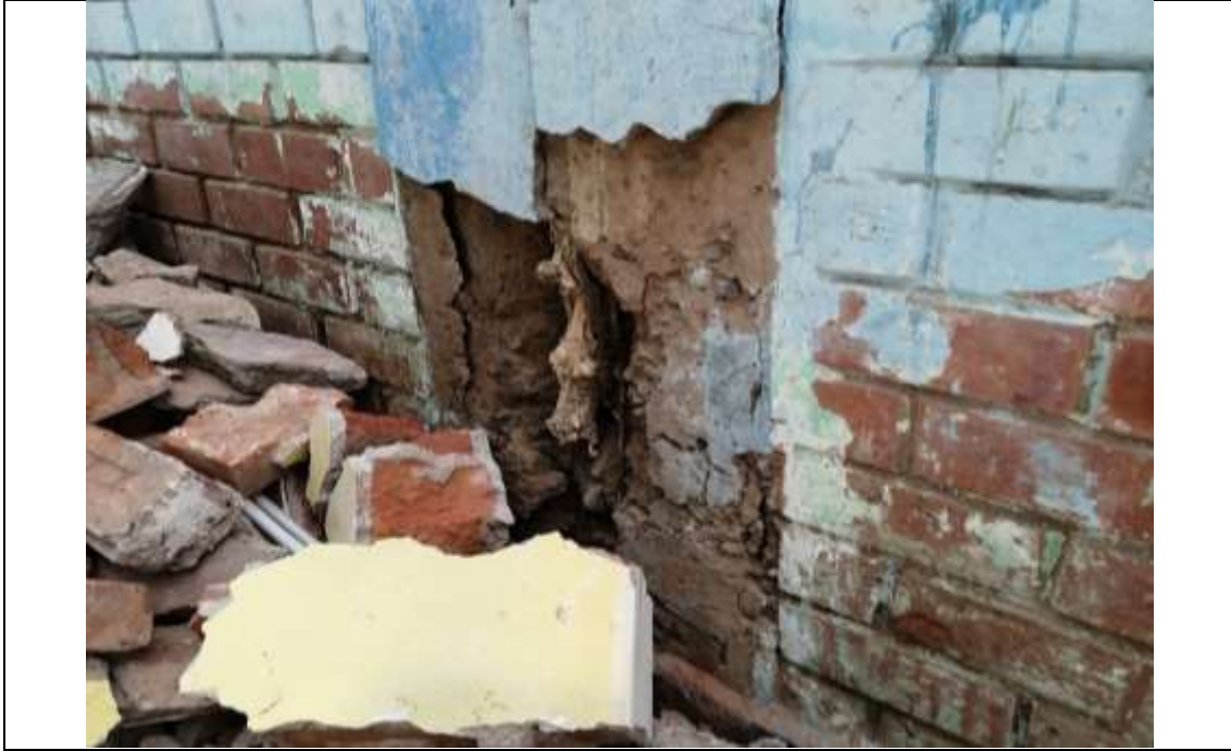
Columna de I. E. corroído por el óxido con riesgo de colapso de la pared.
