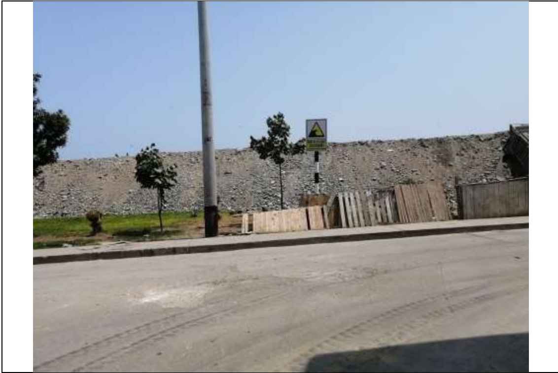
Señales informativas por peligro de tsunami
