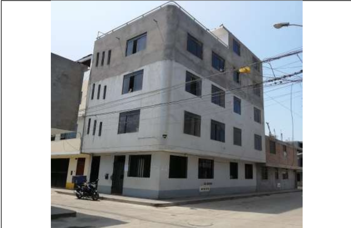
Edificaciones de 4 a 5 pisos que podría utilizarse como refugio previa evaluación estructural
