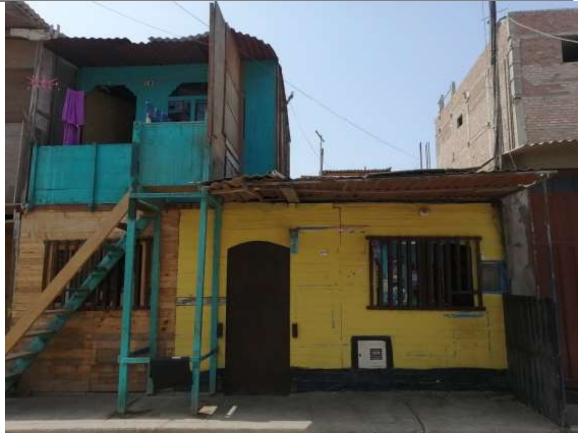
Vivienda precaria con instalación de gas natural
