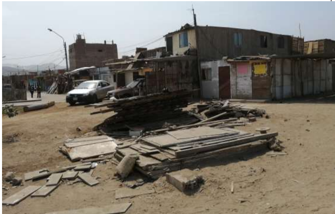
Vivienda de la Mz 118 A construida con madera material precario muy vulnerable ante un tsunami
