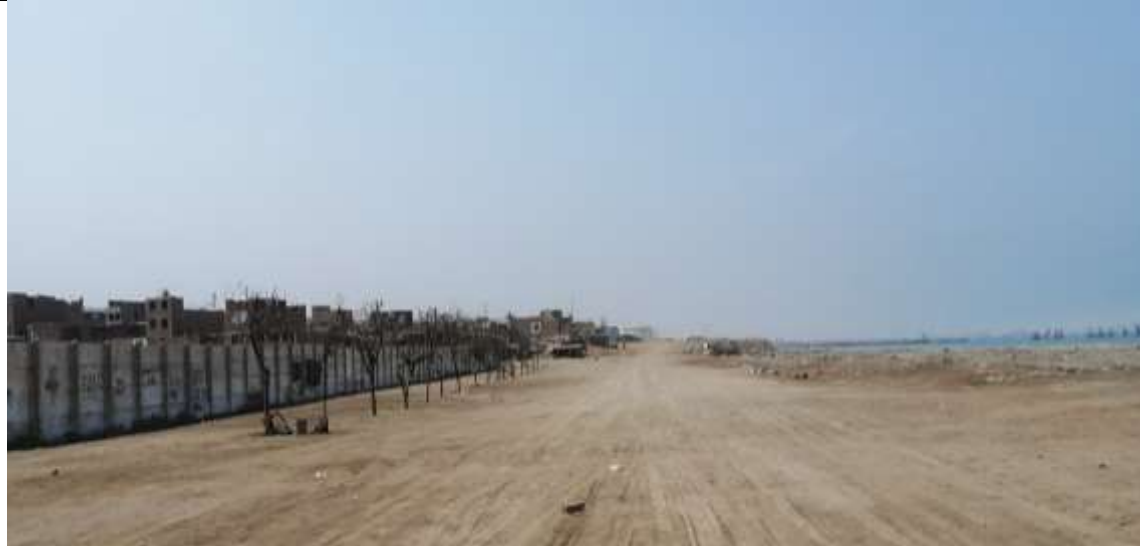
Muro de la cancha de futbol proximidad al mar.
