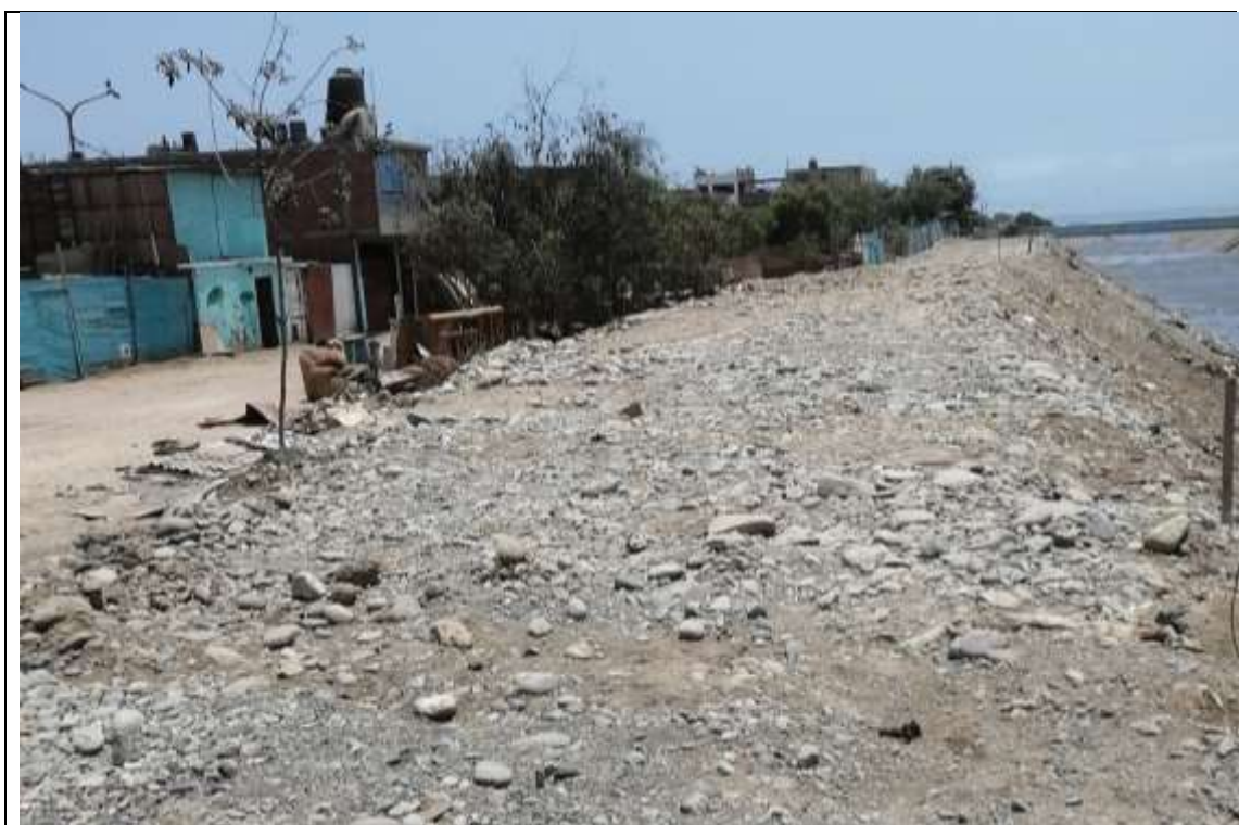
Ribera de río cercana a viviendas precarias. No hay obras de mitigación ante inundaciones fluviales
