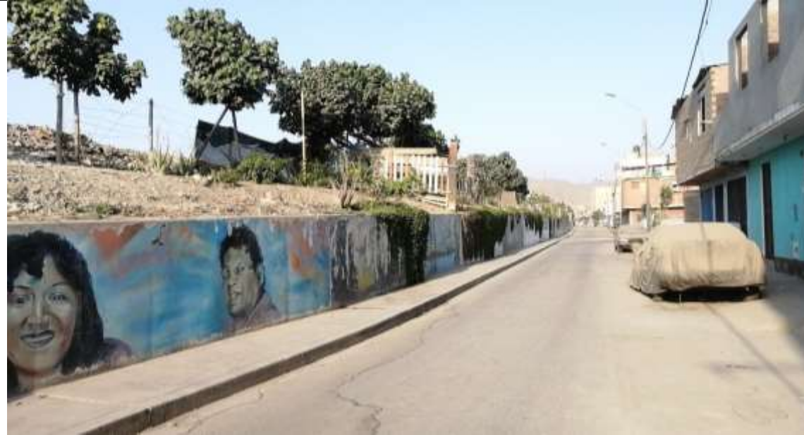
Muro de contención para evitar el deslizamiento del material suelto en la vía vehicular.
