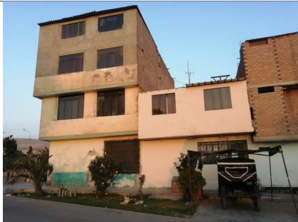
Edificaciones en A.H. Marquez Mz 98 cercana a ribera de río
