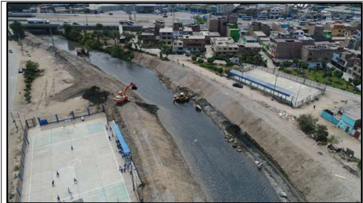
Vista aérea del cauce del río Chillón, se verifican que se están ejecutando trabajos de descolmatación y encauzamiento.
