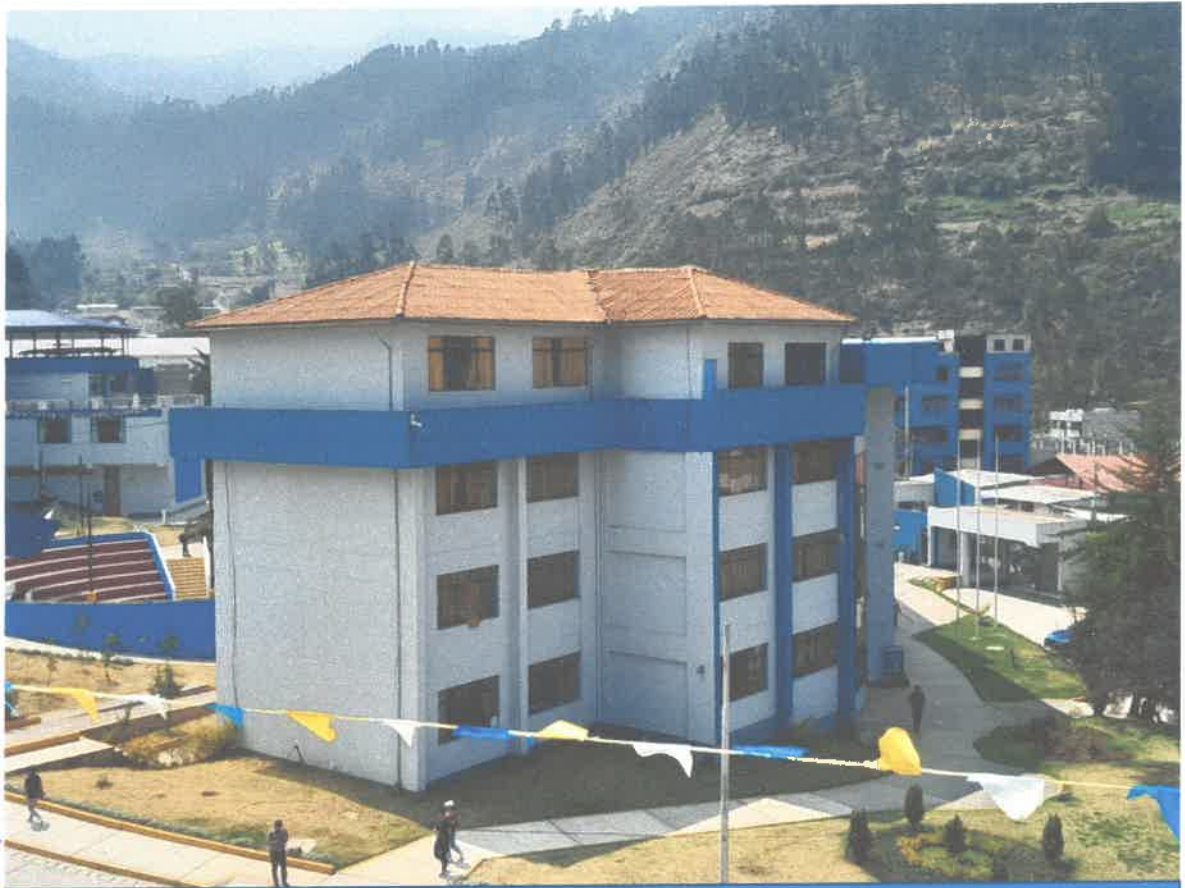
Foto No 4: se observan edificios de hasta 4 a 5 pisos, los cuales presentan vulnerabilidad ante el peligro sísmico, entre ellos el edificio de aulas generales, el edificio de ciencias políticas y gobernabilidad, y el edificio de Ingeniería de minas.
