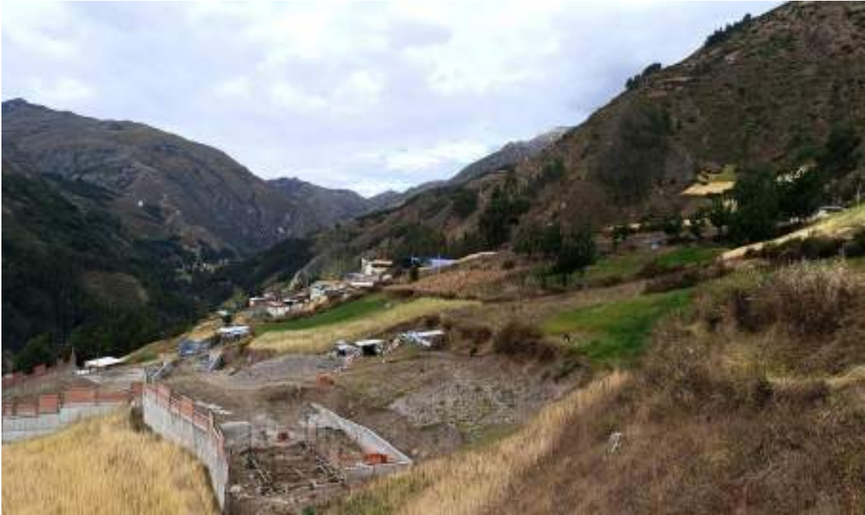
Fotografía 1. Vista de depósito coluvio deluvial 1, sobre el cual se han asentado viviendas y se ha construido infraestructura.
