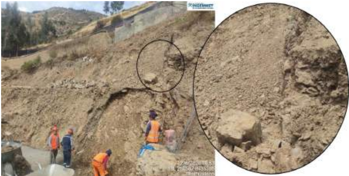
Figura 3.13. Depósito coluvio-deluvial 1, se observa la roca alterada y deformada que corresponde al cuerpo del deslizamiento, debido al gran fracturamiento de las rocas estas se utilizan como material agregado.
