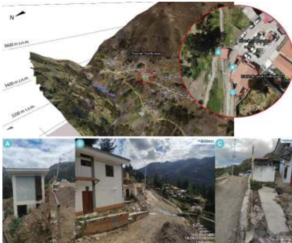
Figura 5.6. Daños en el puesto de salud de Challhuayaco.
