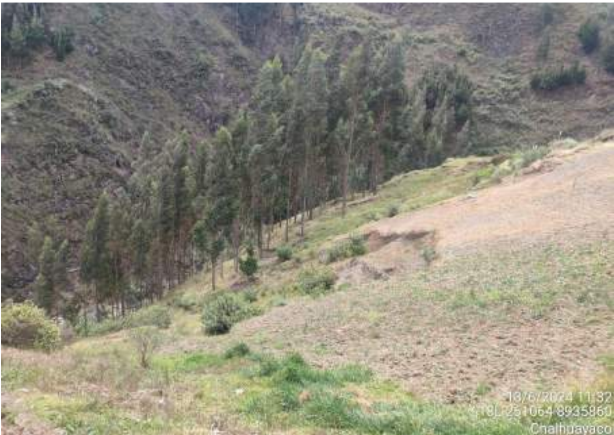
Fotografía 2. Vista del pie de la ladera de Challhuayaco, donde se observa reactivaciones en forma de derrumbes y deslizamientos.
