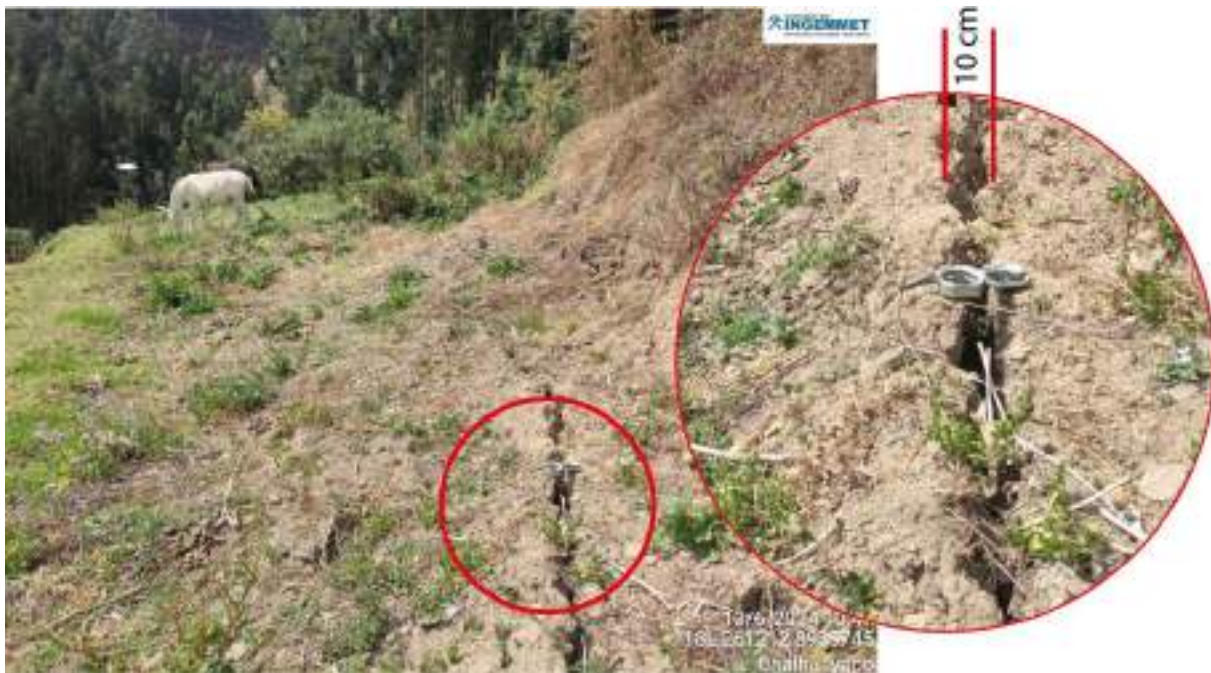
Figura 5.8. Grieta en la parte baja de la ladera en cuerpos de deslizamientos activos, con movimiento hacia el noreste. Coordenadas UTM WGS84: 261212, 8935745.
