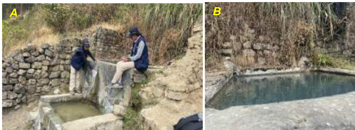
Figura 7.2. A, B) Captación de agua con estructura de concreto, correspondiente al manantial con código 498996-001.
